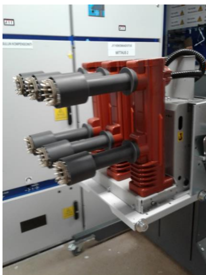
Figur 6: SF 6 -gasbrytare.
