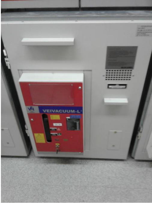
Figur 7: Vakuumbrytare.
