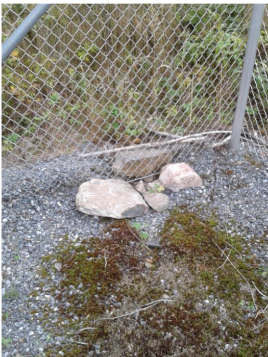
Figur 4: Hur man har underhållit staketet på elstationer som är godkänt granskat.
