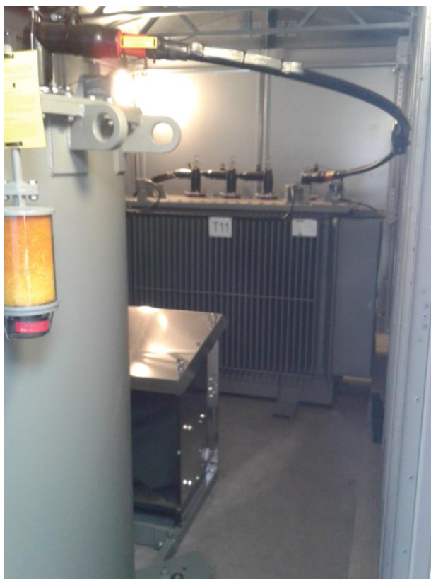
Figur 11: En kompenseringsutrustning.
