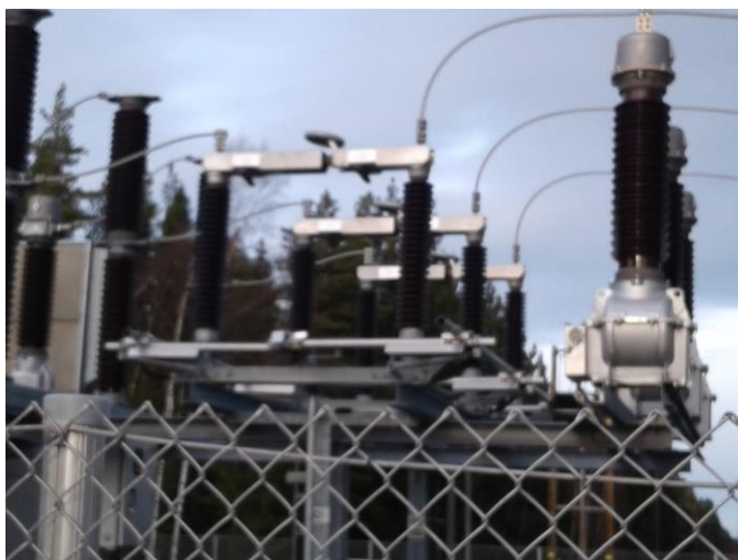
Figur 8: 45-110kV brytare.
