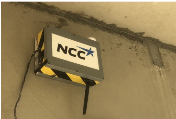
Kuva 8. RuuviTagin Gateway seinälle asennettuna.
