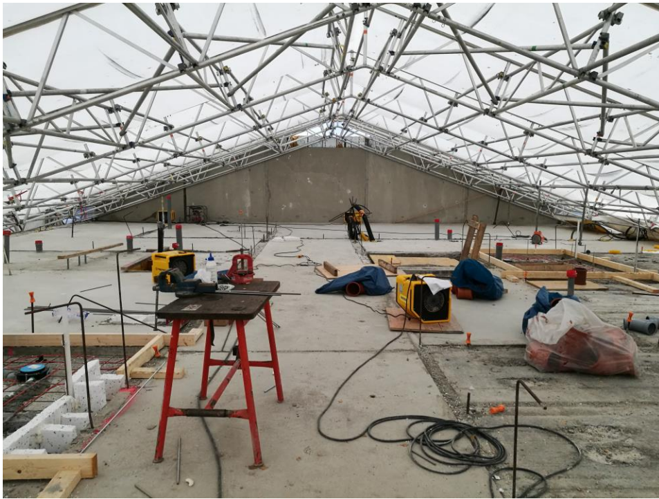
KUVA 3. Kuvassa sääsuojahalli suojaa rakennuksen holvia sateilta.
