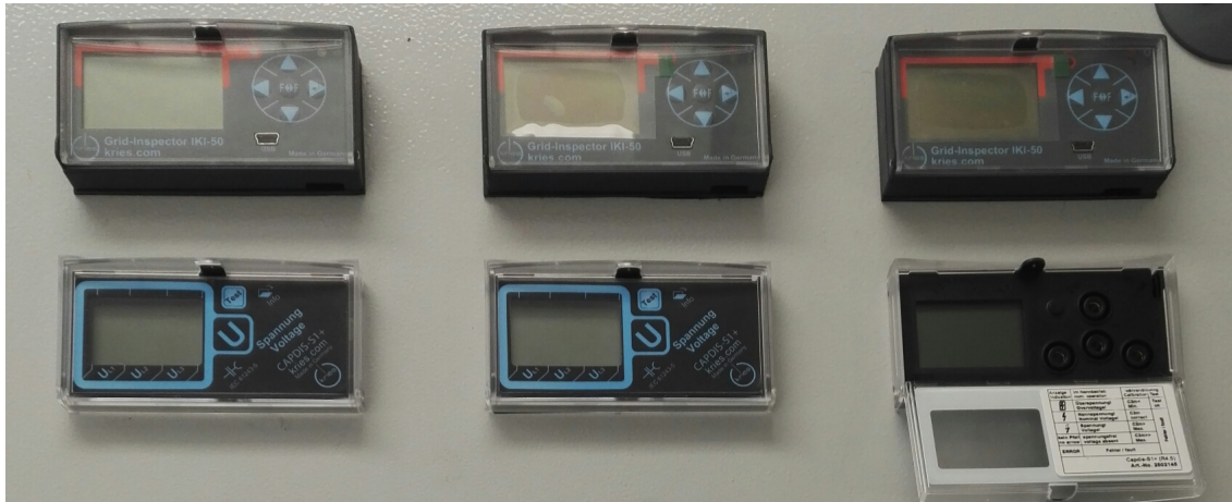
Kuva 7. Kriesin IKI -vikaindikaattoreita ja CAPDIS -jänniteilmaisimia laitakaapin kanteen kasatuna. Oikealla jänniteilmaisimessa vaiheistamisen mahdollistavat kosketussuojatut liittimet näkyvillä.
