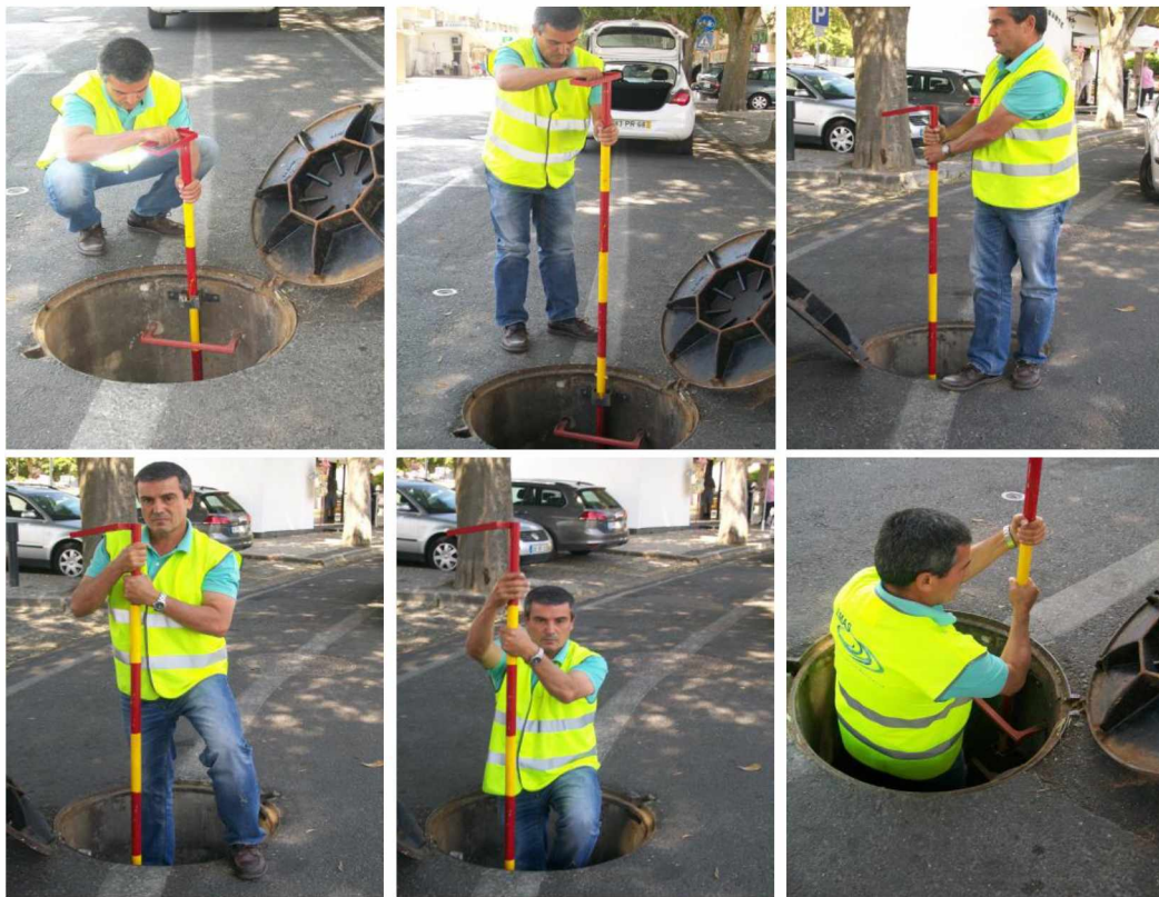
Figura 9. Entrada com equipamento auxiliar
