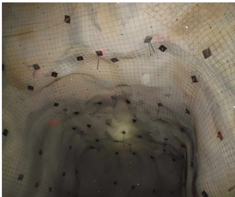
Figura 4 - Zona de trabalho com sustimento
