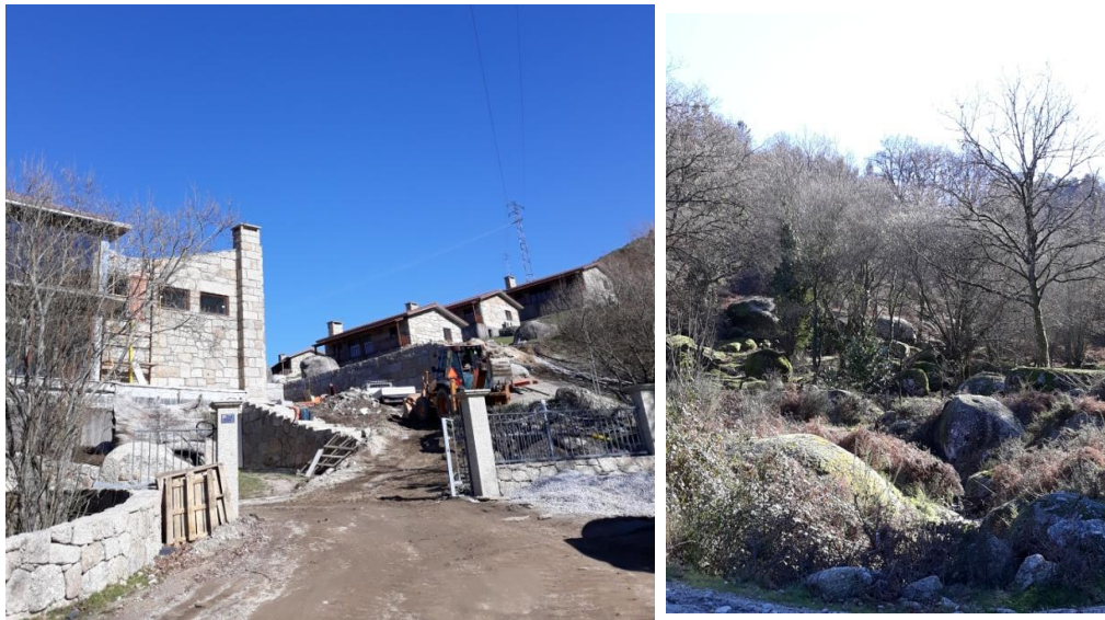
Figura 21. Empreendimento turístico em construção e paisagem, localizados na freguesia de Louredo
