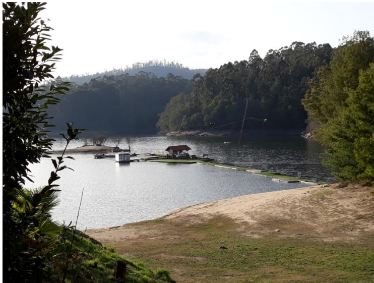
Figura 13. Parte do teleski da barragem do Ermal
