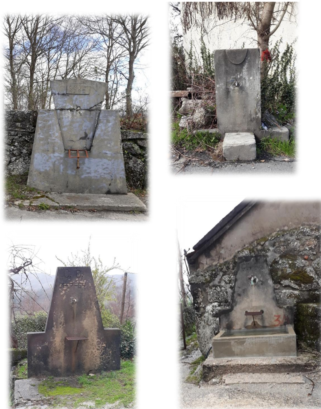
Figura 26. Fontanários que se localizam nas aldeias do município de Vieira do Minho, construídos em cimento
