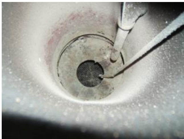
Figura 5-17: Vista interna do reator após retirada das cinzas
