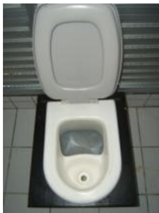
Figura 4-1: Uma das bacias sanitárias secas, segregadoras, utilizadas para coleta dos excretas humanos na ETE – UFES.
