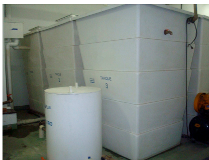
Figura 2: ETAC em escala real instalada na edificação
