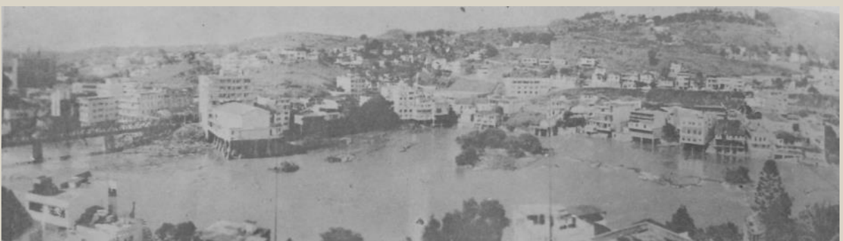
Figura 80: Vista parcial da área antes do aterro.
