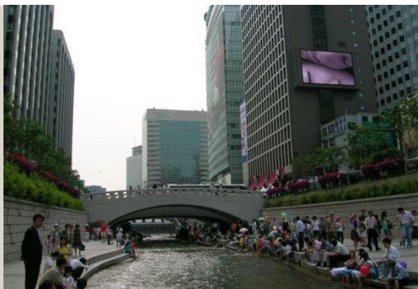
Figura 11: Canal recuperado. Fonte: Petrescu, 2007.
