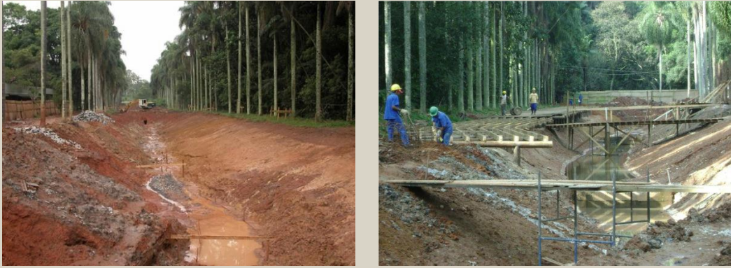
Figura 29: Fase de descanalização do córrego e construção do deck.
