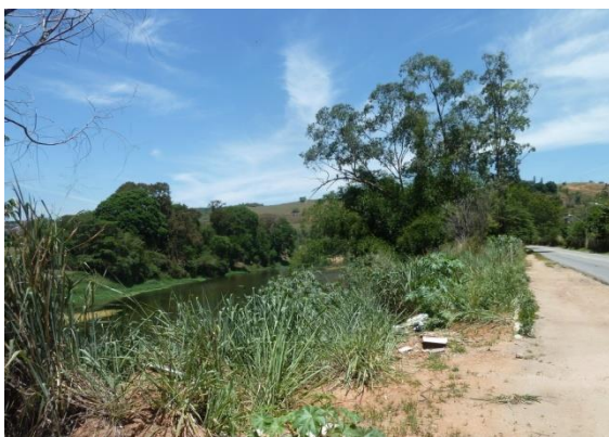
Figura 96: Situação do trecho 3, rodovia na margem direita do rio.
