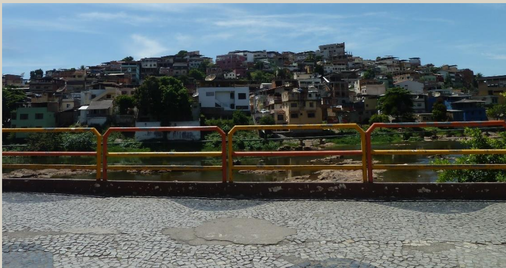
Figura 105: Trecho 8 - Calçada da Av. Beira Rio (margem direita) com o bairro Aquidaban ao fundo. Fonte: Autora, 2015.
