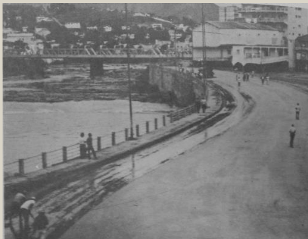
Figura 81: Avenida Beira-Rio em construção.
