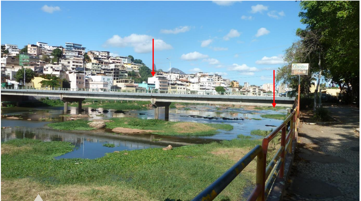
Figura 126: Vista Parcial da cidade 1 - Itabira e Ponte de Ferro (setas vermelhas). Fonte: Autora, 2016.
