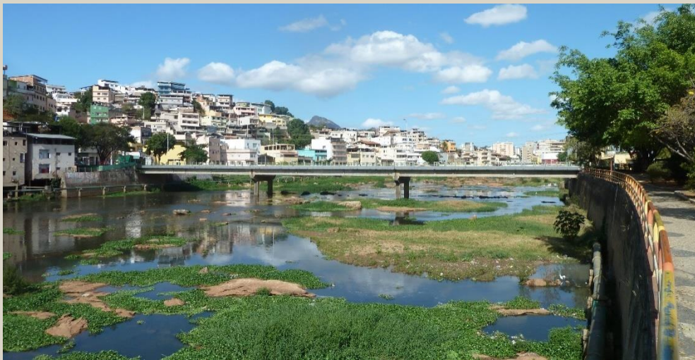
Figura 104: Ponte ao fundo, limite entre os trechos 7 e 8. Fonte: Autora, 2015.
