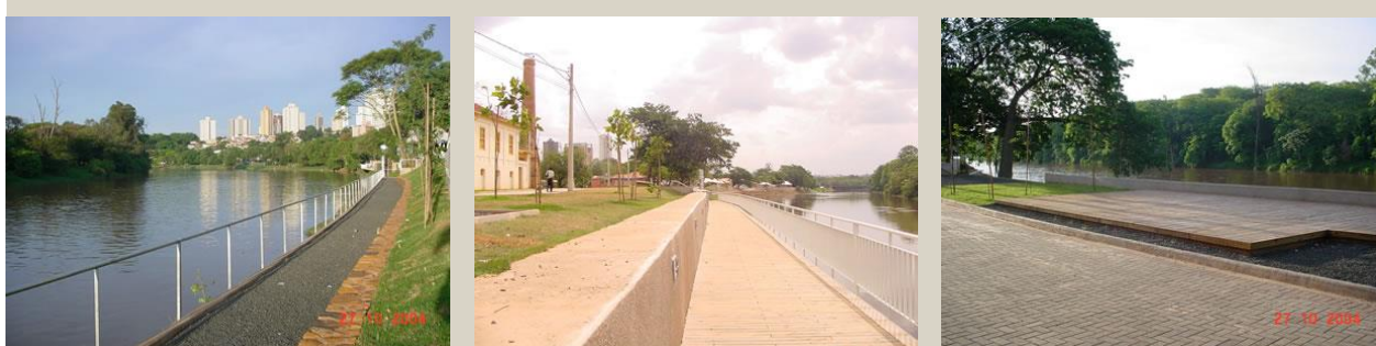
Figura 27: Intervenções na Rua do Porto.
