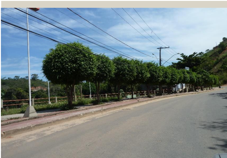
Figura 107: Trecho 9 - Calçamento arborizado (margem esquerda).
