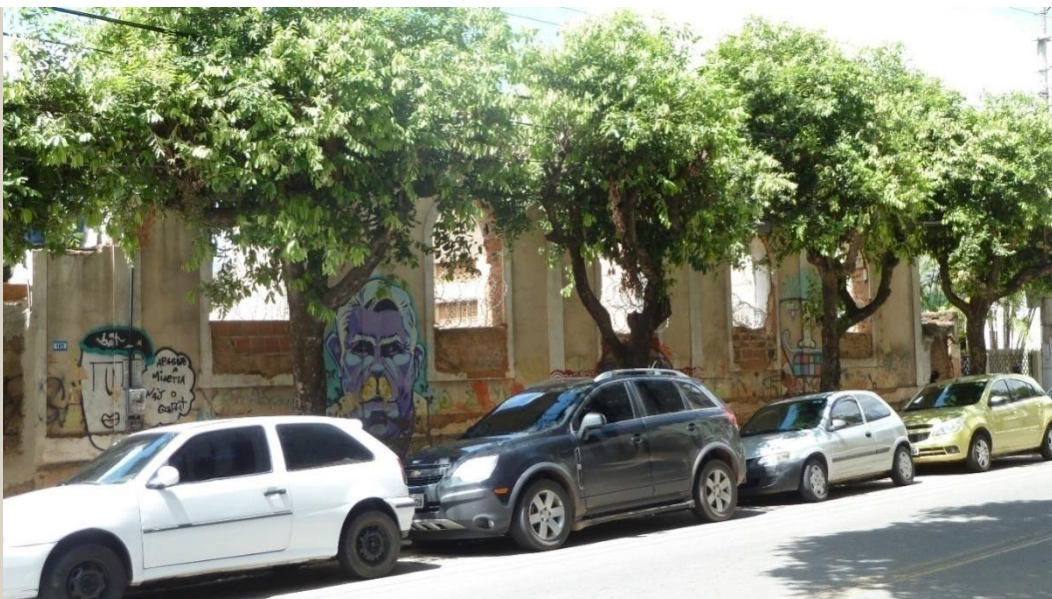
Figura 122: Fachada da "Casa das Teixeiras", com caricatura de Rubem Braga. Fonte: Autora, 2016.
