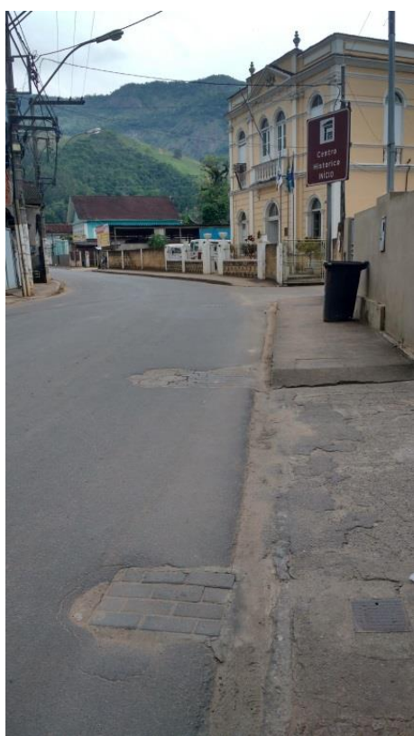
Figura 61 - Alteração de parte da pavimentação da via: (a) lateral da via, (b) centro da via
