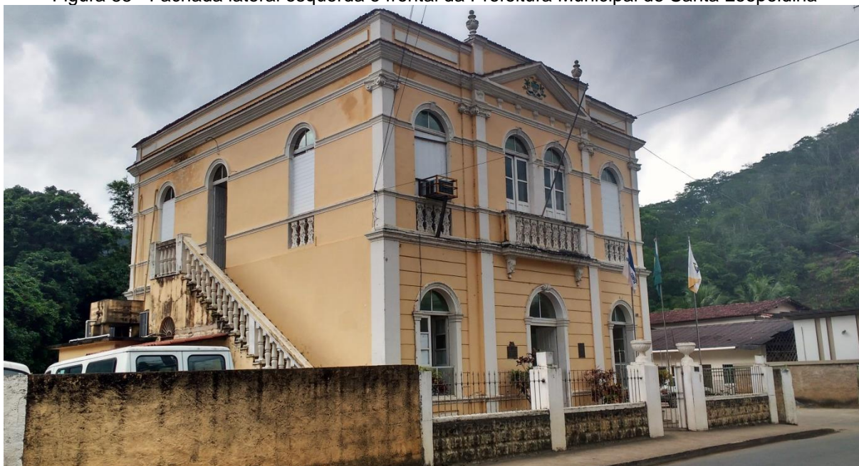
Figura 88 - Fachada lateral esquerda e frontal da Prefeitura Municipal de Santa Leopoldina
