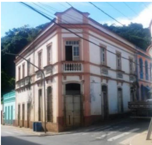
Figura 75 - Imóvel 03 e alvenaria do térreo exposta
