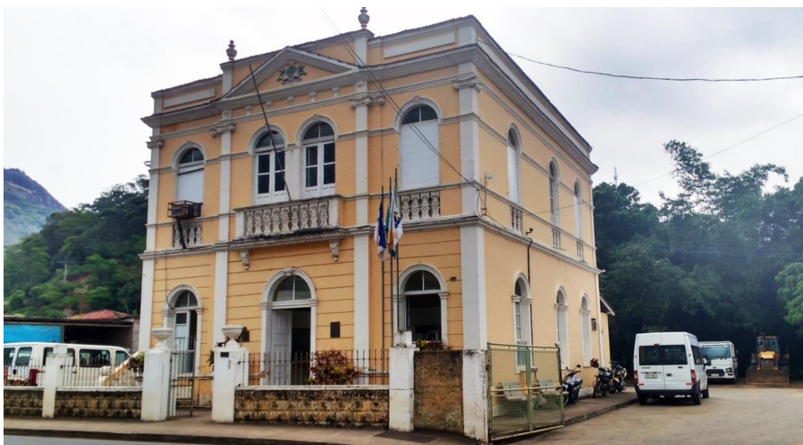
Figura 89 - Fachada lateral direita e frontal da Prefeitura Municipal de Santa Leopoldina
