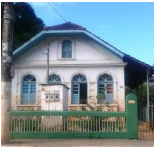
Figura 74 - Imóvel 29 e alvenaria exposta
