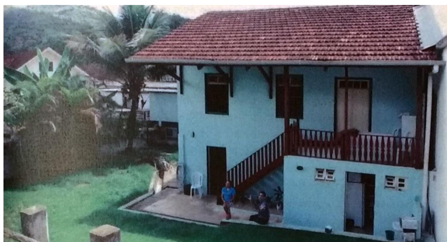
Figura 79 - Fachada posterior do Museu do Colono, antes da ampliação [2015]
