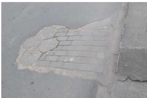
Figura 62 – (a) Alteração de parte da pavimentação da via, (b) pequenas fissuras no asfalto
