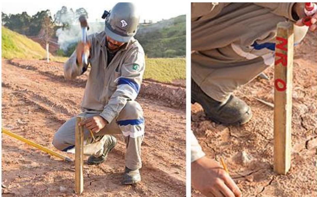
Figura 43 - Marcação com piquete de madeira
