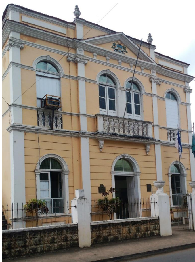
Figura 87 - Fachada frontal da Prefeitura Municipal de Santa Leopoldina
