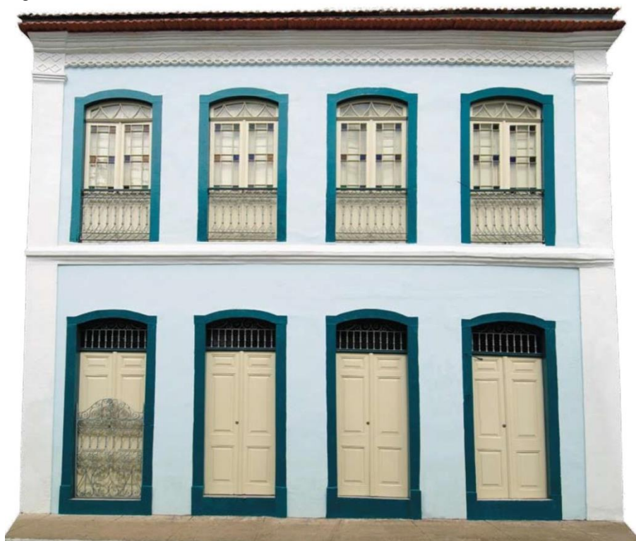
Figura 78 - Fachada frontal do Museu do Colono
