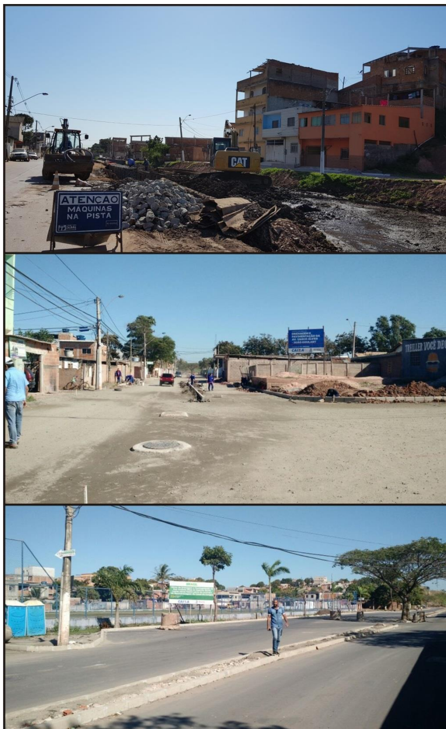
Figura 20 - Obras de pavimentação e drenagem em ruas do bairro Ulisses Guimarães, João Goulart, Jabaeté e Terra Vermelha.
