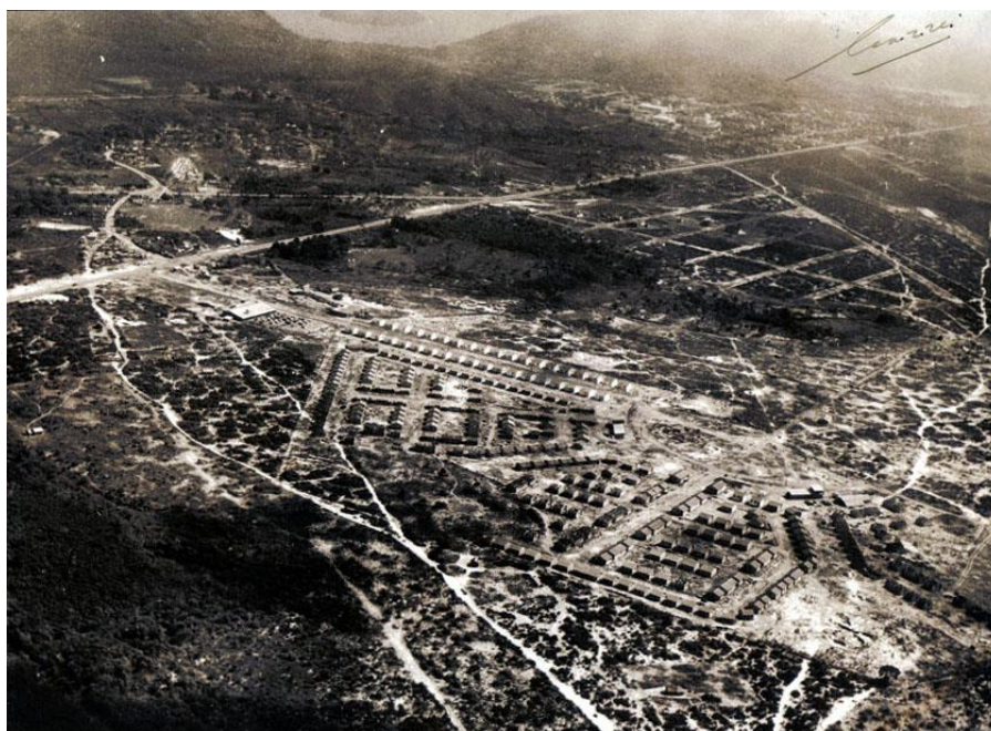
Figura 8 - Vista aérea da construção do IBES e sua inserção urbana
