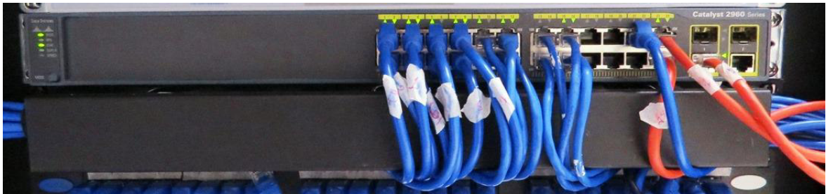
Figura 6.3: Imagem do switch físico Cisco Catalystic 2960
