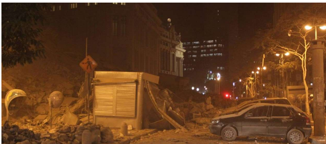
Figura 1.1 - Desabamento do Edifício Liberdade
