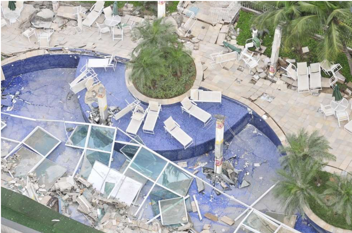
Figura 1.2 - Desabamento na área de lazer do Residencial Grand Parc
