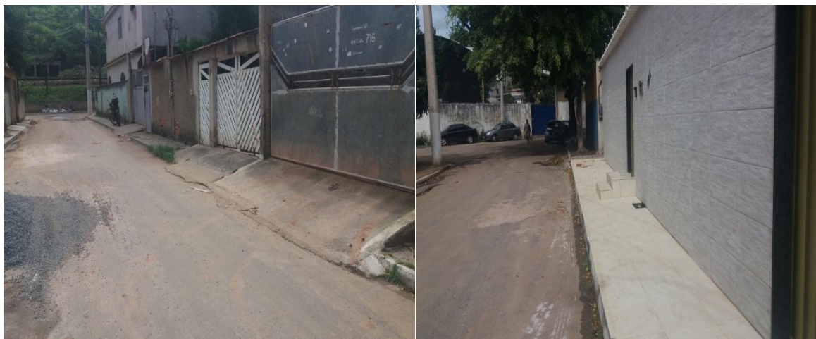
Figura 36 - Casas com marcas de inundações nos muros e com elevações em relação ao nível da rua em Porto de Santana.
