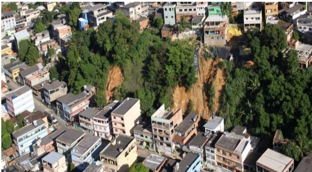
Figura 37 - Deslizamento ocorrido no bairro Porto de Santana em 2013. Fonte: Prefeitura Municipal de Cariacica - PMV / Conteúdo Digital.
