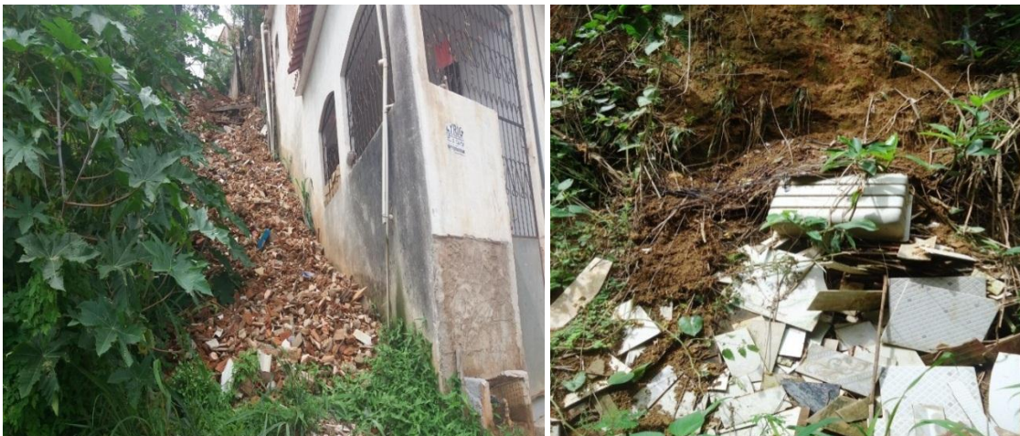
Figura 34 - Lançamento de lixo e entulhos em encosta em Porto de Santana. Foto: Marcela Moraes / Abril – 2016.
