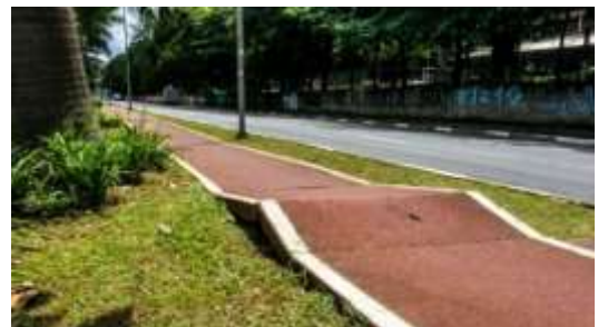
Figura 36 – Ciclovia situada na zona norte de São Paulo sofreu dilatação da pista e provocou acidentes
