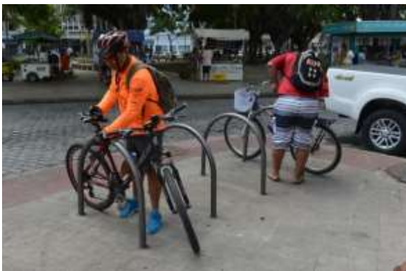
Figura 37 – Paraciclo em U invertido instalado em Vitória
