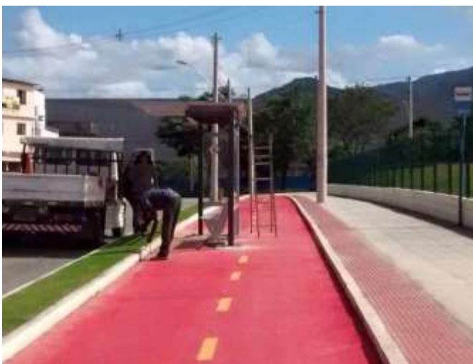
Figura 35 – Ponto de ônibus instalado no meio da ciclovia, Colina de Laranjeiras, Serra, ES
