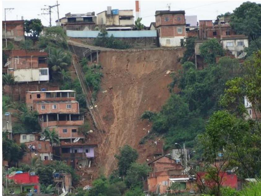
FIGURA 3 – Deslizamento de terra no bairro São Marcos no ano de 2013
