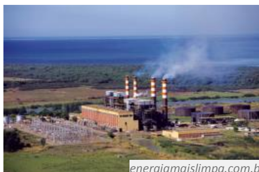
Figura 27. Na foto de termoelétrica, repare na geração de fumaça e na proximidade de mar, para uso de água abundante para resfriamento da condensadora, como no esquema ao lado; esquema de funcionamento (repare que a diferença entre esta usina e a hidroelétrica, é o que faz girar o gerador).
