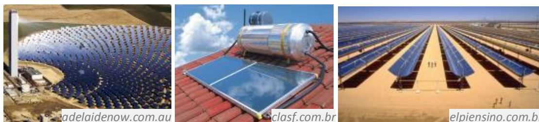
Figura 16. Espelhos direcionam raios solares para uma torre, onde há água, que é aquecida pela Energia térmica; um Boile, onde a água passa por canos pintados de preto (que absorvem mais luz), absorvendo assim Energia térmica do Sol e armazenada num recipiente isolado termicamente; células fotovoltaicas, que captam Energia luminosa do Sol, transformando-as diretamente em Energia elétrica.
