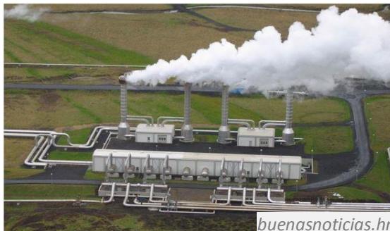
Figura 29. Foto de uma usina geotérmica: repare que a fumaça que se vê, assim como na termonuclear, é vapor da água usada para resfriar o vapor que gira a turbina. As tubulações são as que trazem vapor do subsolo e também que repõem água para o mesmo, após resfriadas por água que também é trazida por tubulações; esquema da usina: repare na semelhança entre as usinas que utilizam vapor de água e turbinas acopladas a geradores.
