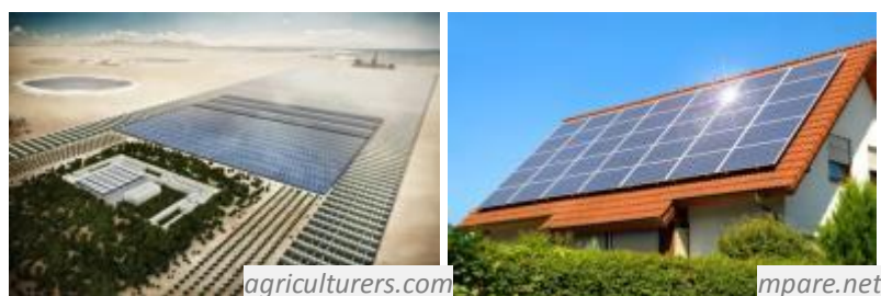
Figura 33. Usina solar num deserto: a quantidade monstruosa de células é devido à sua baixa eficiência; uma casa sendo alimentada por algumas placas com células fotovoltaicas.
