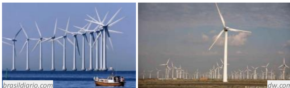
Figura 14. Usinas eólicas aproveitando a Energia cinética do vento em regiões onde costuma ventar bastante: no mar (ou próximo a ele) e em locais desérticos. Repare que a quantidade de turbinas é grande, pois a potência de cada uma é baixa. Mais uma vez, vemos a importância do Sol na geração dos ventos.
