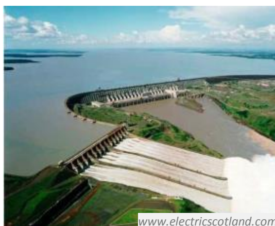
Figura 26. Foto real de uma usina hidroelétrica: uma enorme quantidade de água armazenada na represa pela barragem de concreto (tudo o que existia ali foi retirado ou alagado); no esquema de funcionamento da usina, repare que a água que faz girar o gerador sai da parte inferior da represa (onde há maior pressão), portanto, a água de vemos escapar pela parte de cima (como visto na foto) é o excedente, ou seja, o que o gerador não utiliza, mas é necessário para dar a vazão ao rio.
