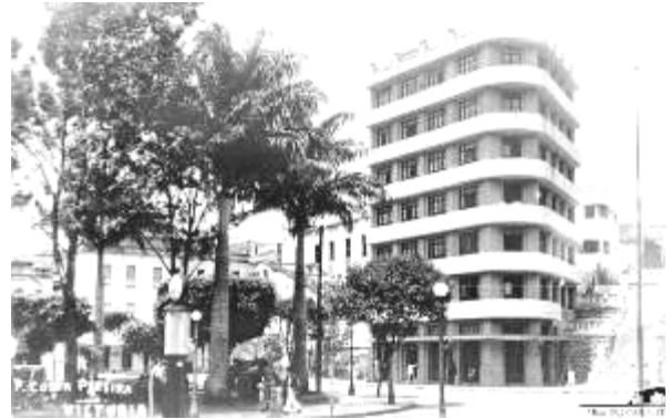
Figura 130 - Praça Costa Pereira. Edifício Antenor Guimarães e Escadaria São Diogo. Fonte: Moraes (1940b).
