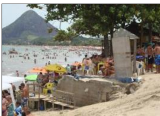
Figura 41: Instalações precárias e perigosas dos estabelecimentos comerciais na praia Central de Piúma.
