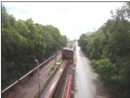
Figura 44: Instalação da mineradora Samarco vista a partir da ES-060.
