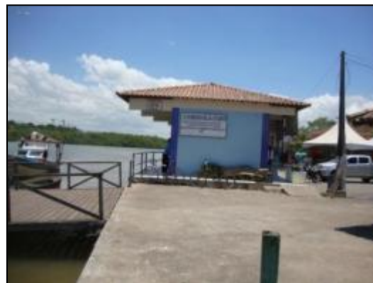
Figura 48: Local de desembarque de pescado em Anchieta. Ao fundo, edificação do Mercado Municipal , que se encontra reformada. Fonte: acervo pessoal.
