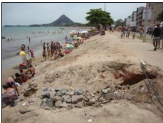
Figura 76: Praia Central de Piúma com processo erosivo.
