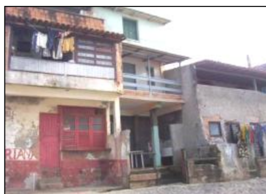
Figura 42: Construção irregular de residências sobre a praia da Areia Preta, em Marataízes.
