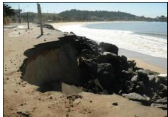
Figura 17: Erosão na praia de Itaoca em 2012.
