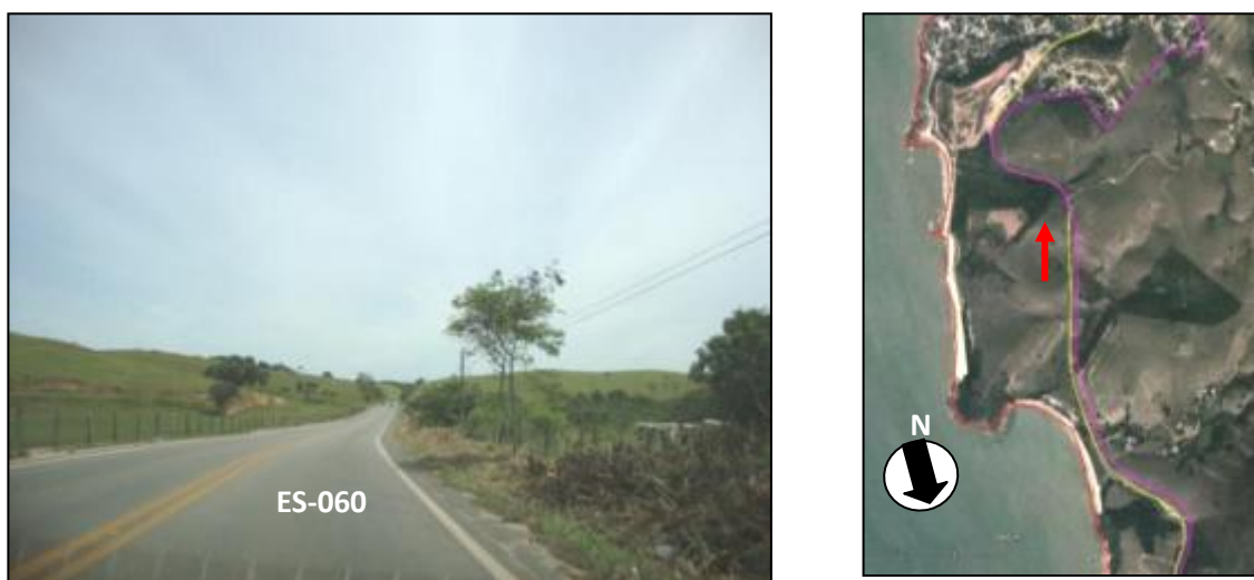
Figura 30: Local onde a ES-060 foi utilizada como limite para a área de trabalho, tendo em vista que não há diferença de uso para além da Rodovia, ou seja, em ambas as margens da Rodovia a característica predominante é rural. Ressalta-se que o sentido da imagem é Itapemirim-Marataízes e o mar encontra-se à esquerda, como se observa na situação na foto à direita.
