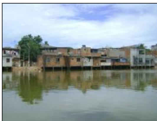
Figura 60: Construções irregulares na margem do Rio Iconha, em Piúma. O local é protegido por lei.
