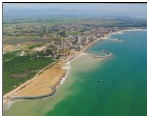
Figura 77: Aterro hidráulico, em execução na época, na Praia Central de Marataízes.
