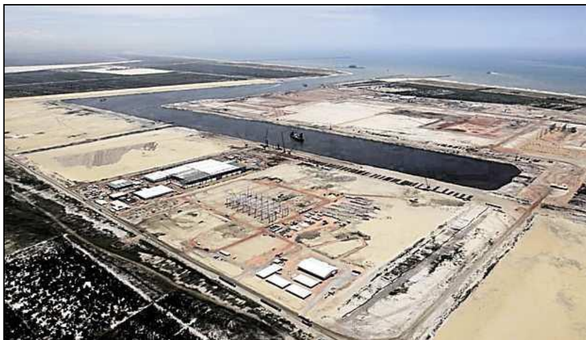
Figura 27: Obras do Porto do Açú no norte fluminense.
