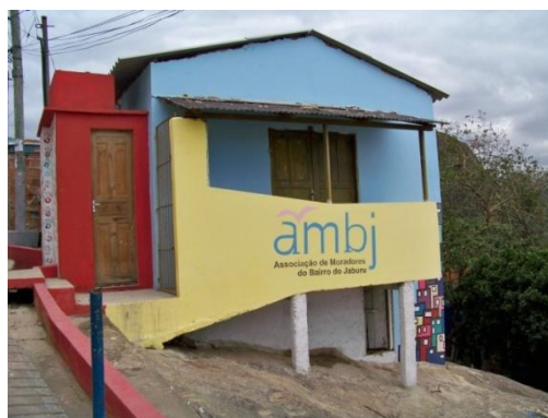
Figura 20: Reforma em mutirão de edificação para futura sede da Associação de Moradores de Jaburu durante o SENEMAU 2010, em Vitória.
