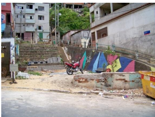
Figura 19: Construção em mutirão de parte do futuro Centro Comunitário de São Benedito durante o SENEMAU 2010, em Vitória.
