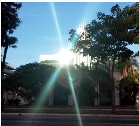
Figura 10: Ao centro da imagem nota-se o ofuscamento devido ao reflexo do sol em edifício com fachada envidraçada composta por vidro reflexivo em Vitória-ES
