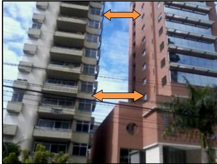
Figura 4 – Em Santa Catarina, escavação realizada para obra do Shopping abala prédio vizinho.
