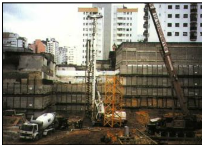
Figura 13 - Etapa inicial cravação de estacas tipo hélice contínua que possuem reduzidos níveis de ruído e vibração.
