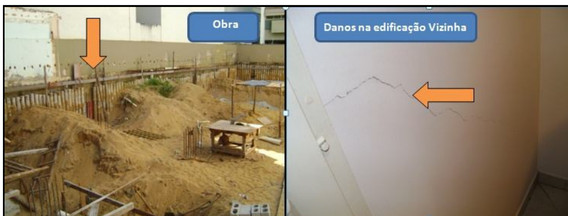
Figura 20 – Obra em andamento na fase movimentação de terra e fissuras surgidas na edificação vizinha.
