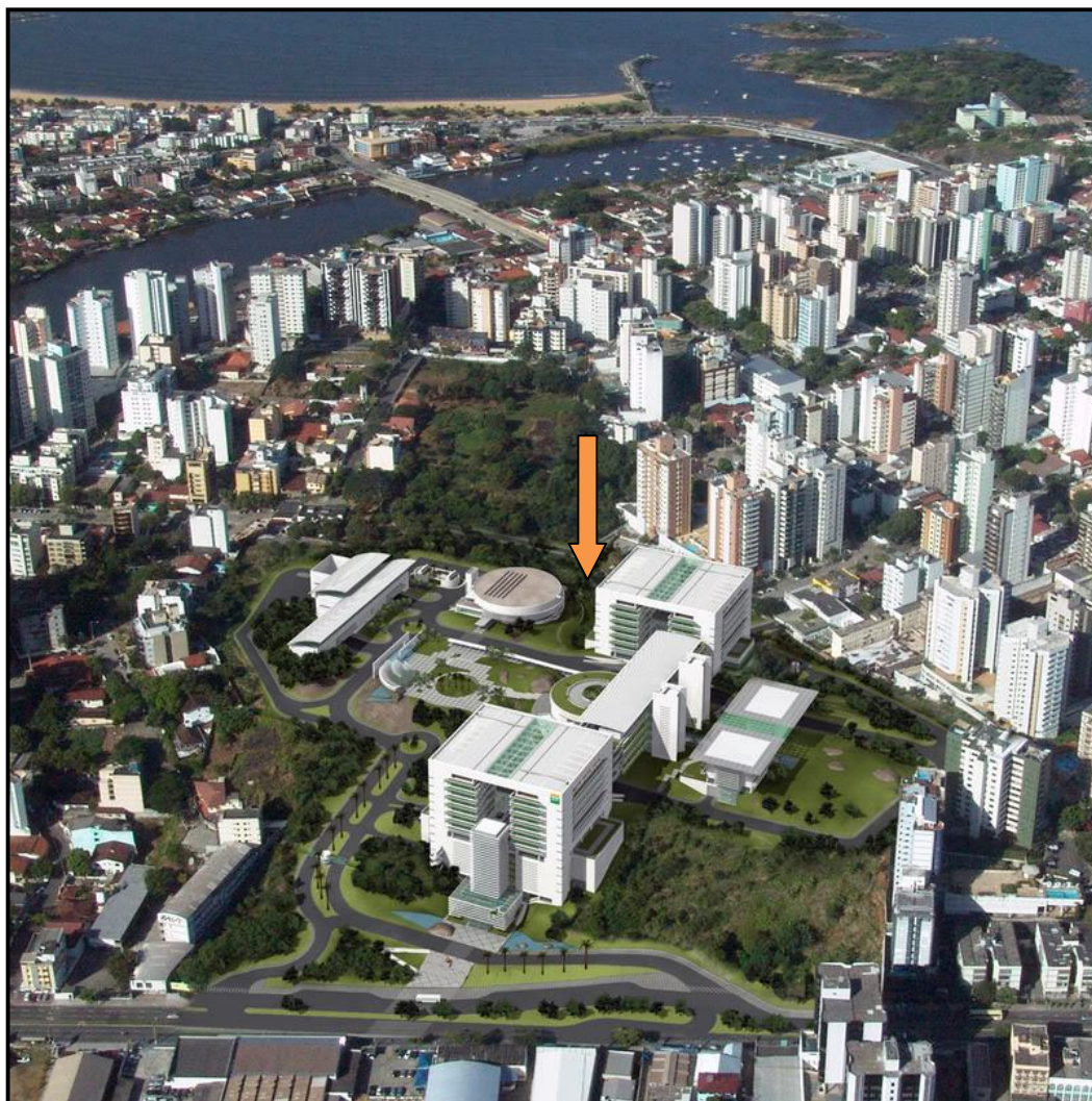
Figura 49 – Sede de empresa e edificações vizinhas.
