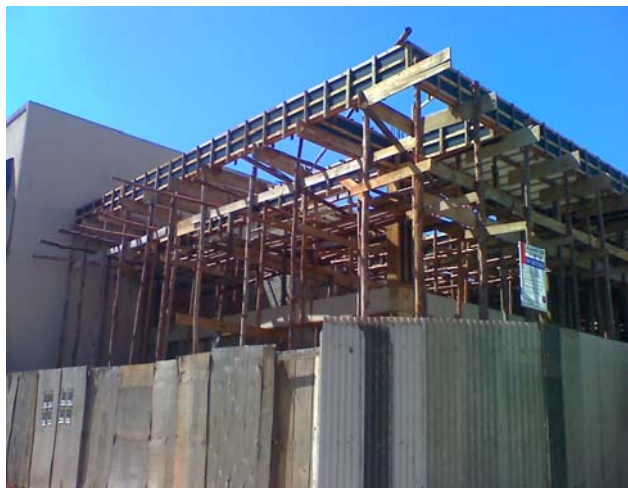
Figura 94 - Obra em Vila Velha (ES) executada em concreto moldado in loco Fonte: Arquivo pessoal
