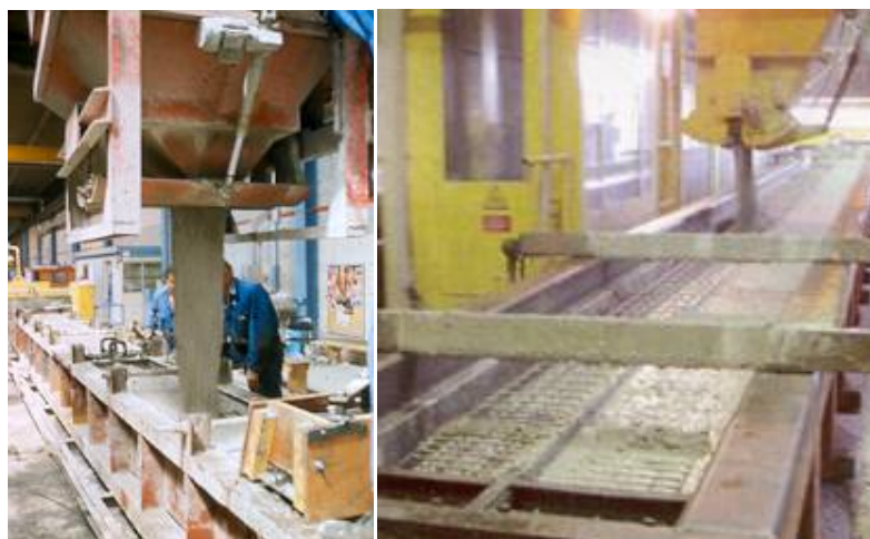
Figura 40 – Fabricação de elementos pré-fabricados em concreto Fonte: FEBE (2009)
