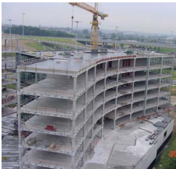
Figura 29 – Construção de edificação em concreto pré-fabricado, onde se observa a organização do canteiro de obras.
