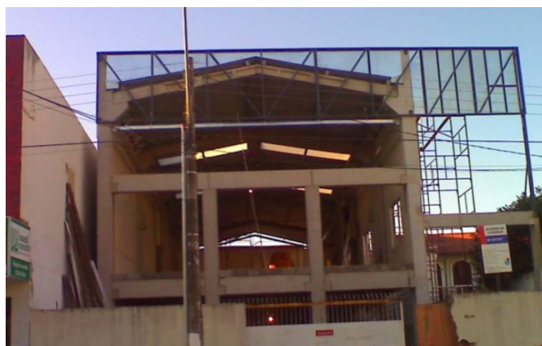
Figura 36 – Estrutura de galpão em concreto pré-fabricado, utilizada para a concepção de uma loja, em Vila Velha, ES.
