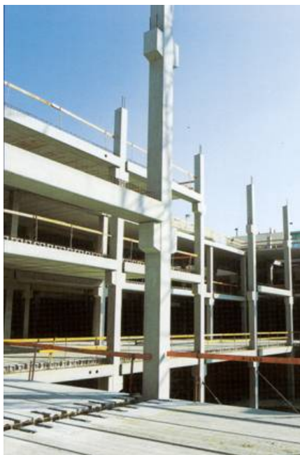
Figura 52 – Pilares com consolos. Fonte: FEBE (2009)
