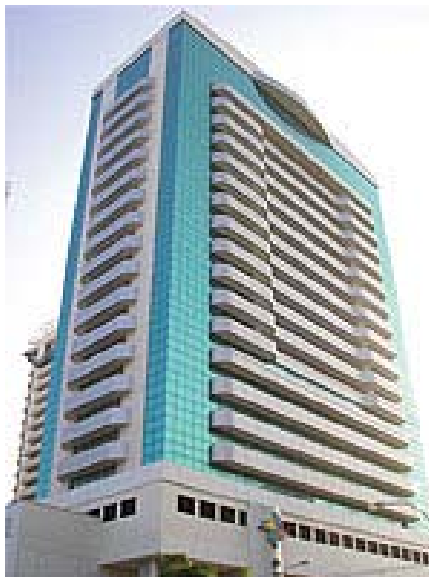
Figura 35 – Edifício localizado em Fortaleza, composto por um shopping, duas torres residenciais de 24 pavimentos e duas torres comerciais de 20 pavimentos. Varandas, grande parte das vigas e lajes são pré-fabricadas, já os pilares e as caixas de elevador foram moldados "in loco".
