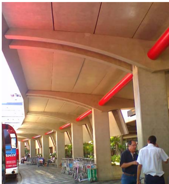
Figura 98 - Aeroporto de Congonhas (SP), cobertura em concreto pré-fabricado, com estrutura aparente.
