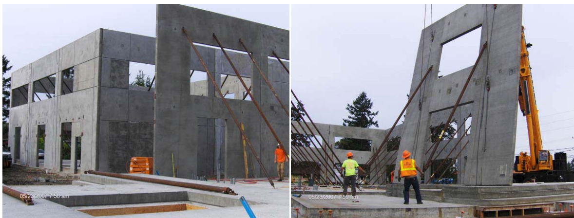
Figura 27 – Construção executada com o uso do sistema tilt up Fonte: www.genconpacific.com/Tilt%20Ups.htm
