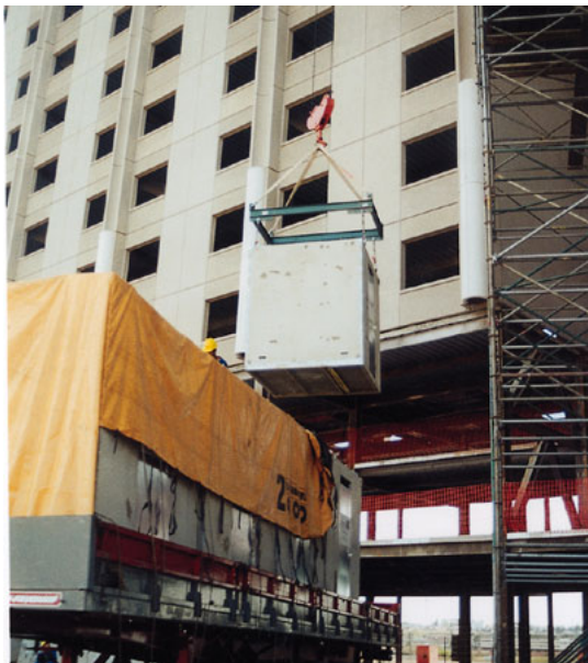
Figura 68 – Transporte de módulo
