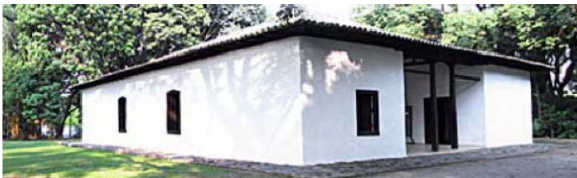
Figura 19 – Casa Bandeirista, no Butantã, em São Paulo, construção em taipa da primeira metade do século XVIII.
