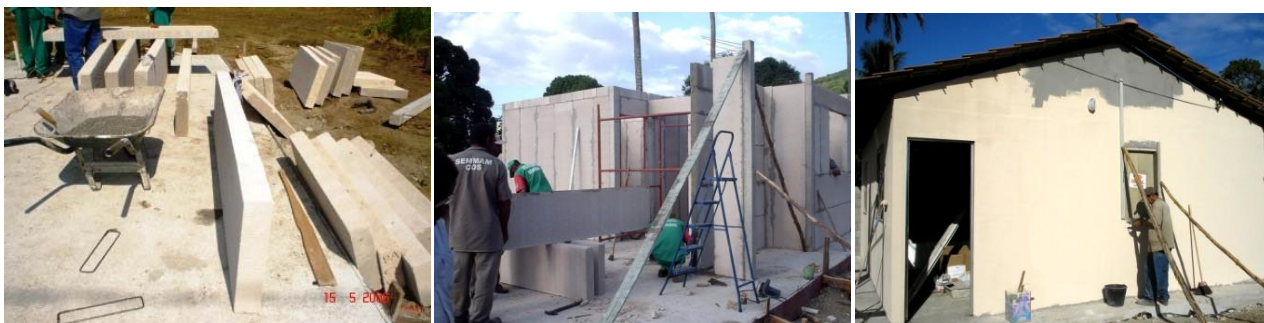
Figura 77 - Sequência de construção de habitação popular utilizando sistema construtivo em concreto pré-fabricado. Fonte: www.vitoria.es.gov.br
