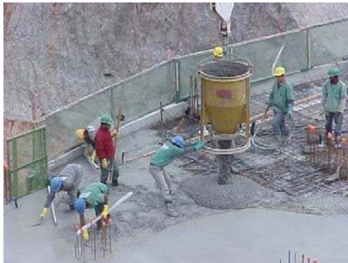
Figura 92 – Obra utilizando o concreto moldado in loco. Fonte: DANTAS (2006) p.22
