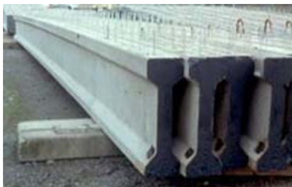
Figura 57 – Vigas tipo “I” Fonte: FEBE (2009)
