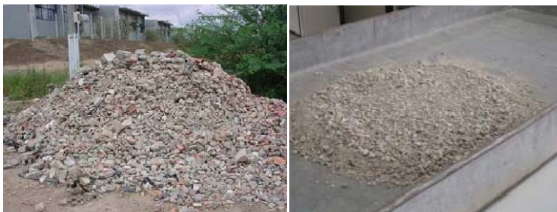
(a) (b) Figura 91 – (a) Resíduos de construção e demolição dispostos no canteiro, antes da separação, (b) e agregado miúdo produzido a partir dele.
