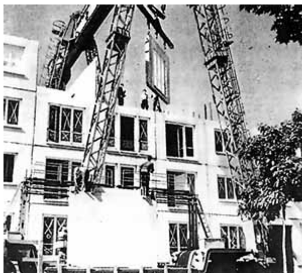
Figura 30 – Montagem de grandes painéis pré-fabricados. Início dos anos 60. Fonte: http://www.vitruvius.com.br/arquitextos
