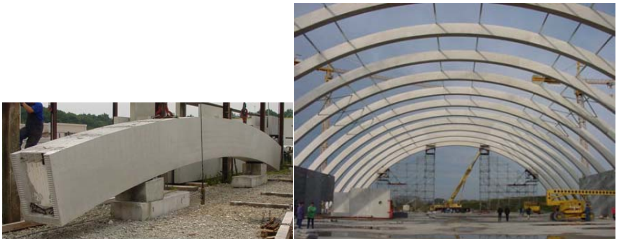
Figura 93 - Vigas pré-fabricadas em arco, com repetição dos elementos, para estrutura de ginásio Fonte: FEBE (2009)
