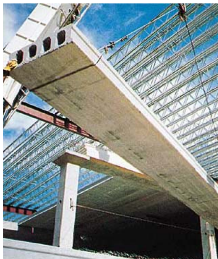
Figura 53 – Laje alveolar Fonte: PROJETODESIGN nº. 256, 2001
