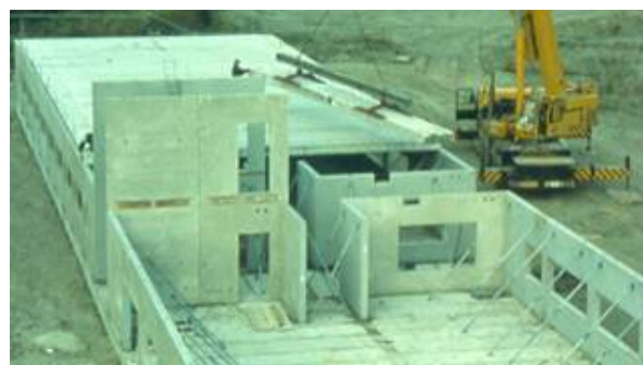
Figura 50 – Construção com paredes portantes, perpendiculares à fachada Fonte: FEBE (2009)
