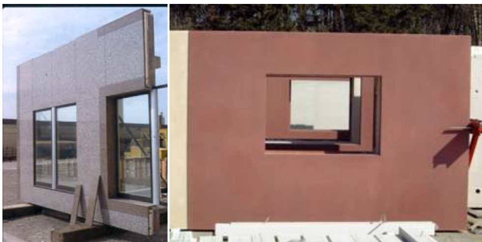
Figura 38 – Painéis de fachada com dimensões e formatos diferentes.
