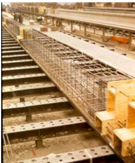
Figura 96 – Armadura utilizada em fábrica de concreto pré-fabricado Fonte: FEBE (2009)
