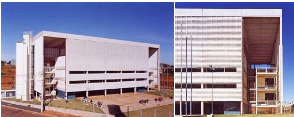
Figura 75 - Escola executada em estrutura pré-fabricada em concreto no município de Campinas, São Paulo.
