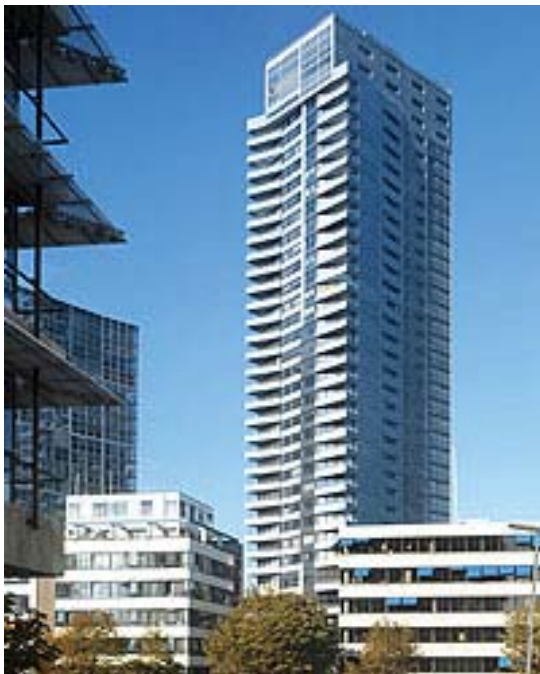
Figura 31 – Edifício localizado em Roterdã, na Holanda, construído de acordo com sistemas construtivos pré-fabricados. Em 2004, época em que foi construído, era considerada a construção mais alta da Holanda nesse sistema.
