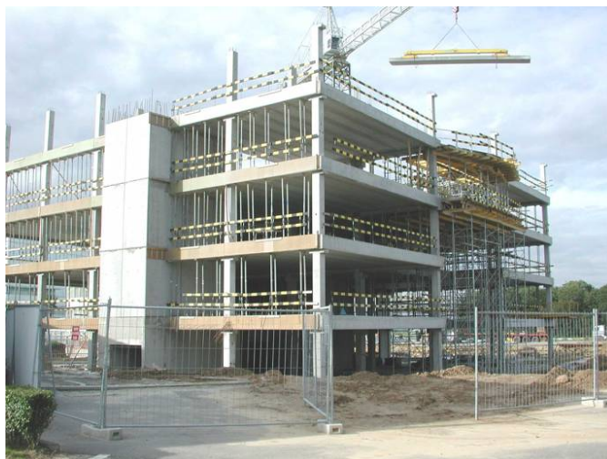
Figura 89 - Exemplo de canteiro de obras com utilização de sistema pré-fabricado em concreto Fonte: FEBE (2009)
