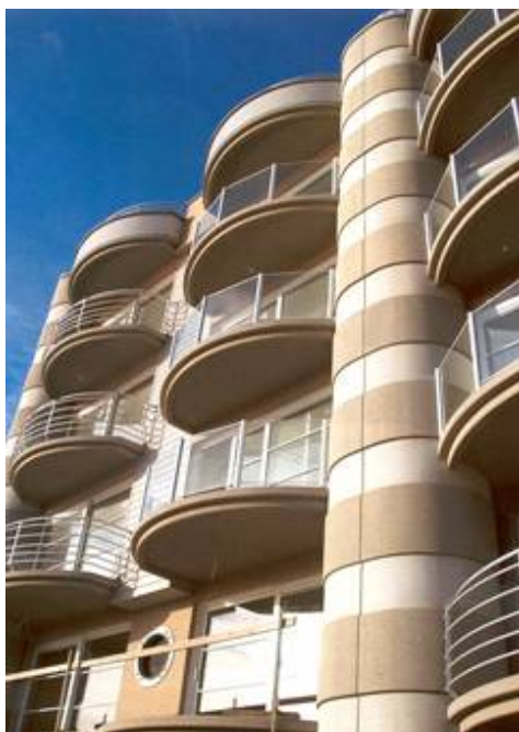
Figura 99 - Edifício de apartamentos executado em elementos pré-fabricados em concreto.
