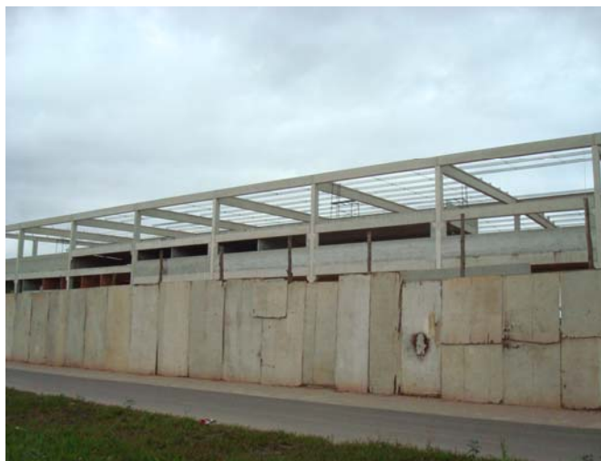
Figura 95 - Obra em Vila Velha (ES) executada em concreto pré-fabricado Fonte: Arquivo pessoal
