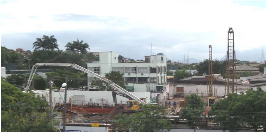
Figura 87 - Exemplo de canteiro de obras com utilização de bate-estacas Fonte: Arquivo pessoal
