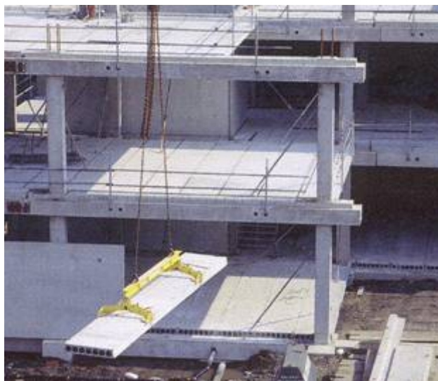
Figura 45 – Montagem de peça pré-fabricada em concreto. Fonte: FEBE (2009)
