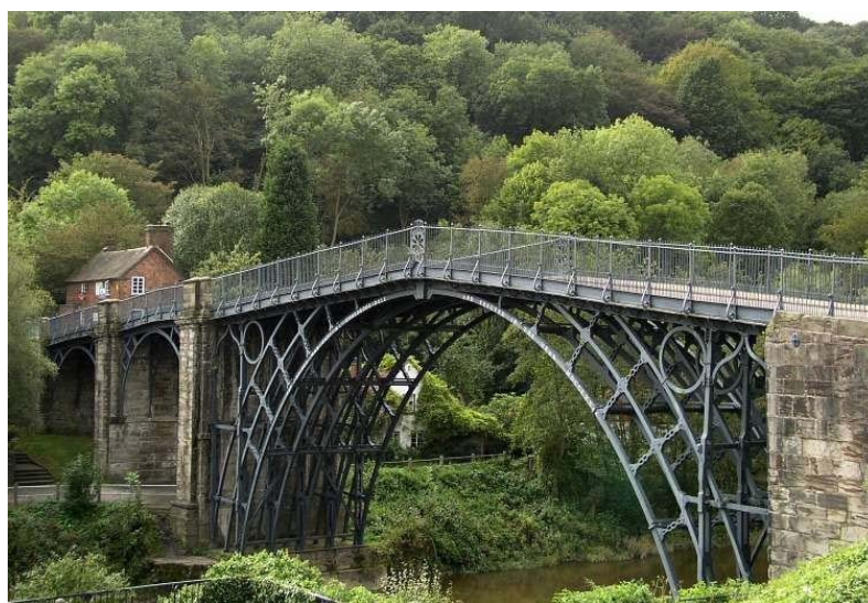
Figura 14 – Ponte Coalbrookdale, na Inglaterra. Construída em 1779, com um vão de 30 metros em ferro fundido.
