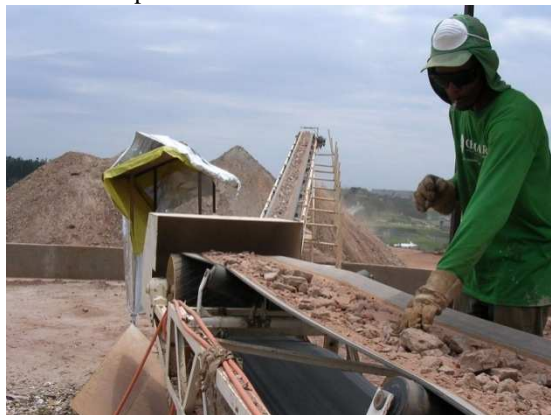
Figura 77 - Realização de triagem secundária na correia transportadora na usina SP 3
