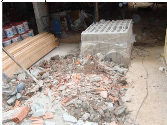
Figura 29 – Pilha de resíduos classe B depositados junto ao estoque de materiais da Construtora D
