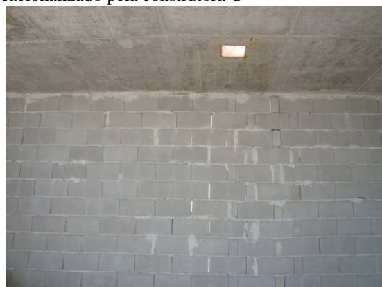
Figura 44 – Paredes com de projeto de alvenaria racionalizado pela construtora C
