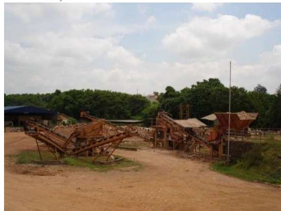
Figura 54 - Vista geral da área de reciclagem da usina SP 2, em Piracicaba
