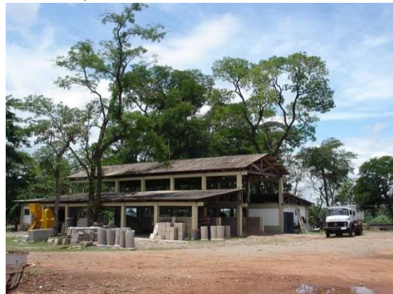
Figura 52 - Fábrica de artefatos de concreto da usina SP 1, em SJRP
