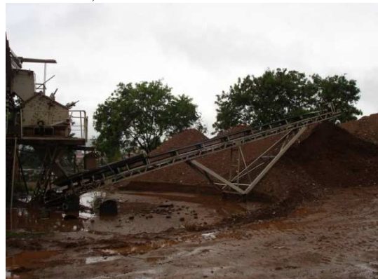
Figura 57 - Vista parcial da área de reciclagem da usina MG 1, em Belo Horizonte
