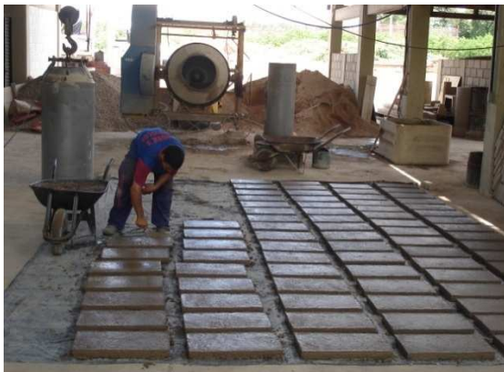
Figura 67 - Fabricação de artefatos em concreto na usina SP 1
