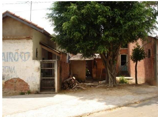
Figura 83 - Edificações situadas junto à entrada da usina SP 2
