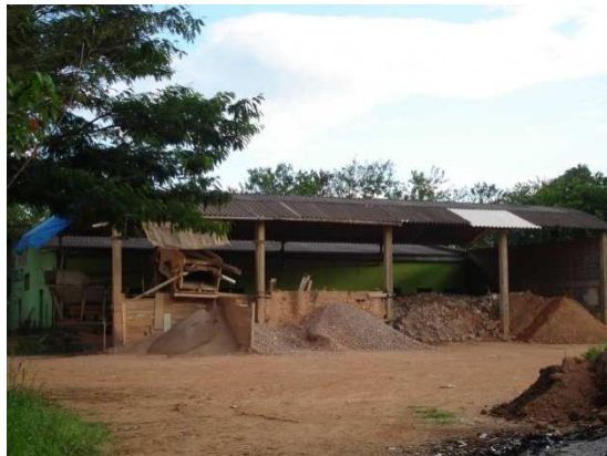
Figura 49 - Vista geral da área de produção e armazenamento de AR da usina SP 6
