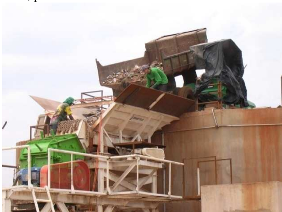
Figura 76 - Realização de triagem primária dos RCC, por funcionários na usina SP 3
