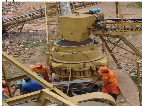
Figura 64 - Realização de manutenção nos equipamentos da usina MG 2
