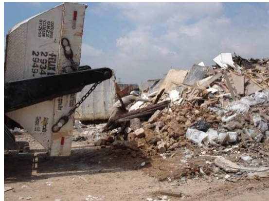
Figura 94 - Deposição de RCC e triagem dos resíduos classe B no mesmo local
