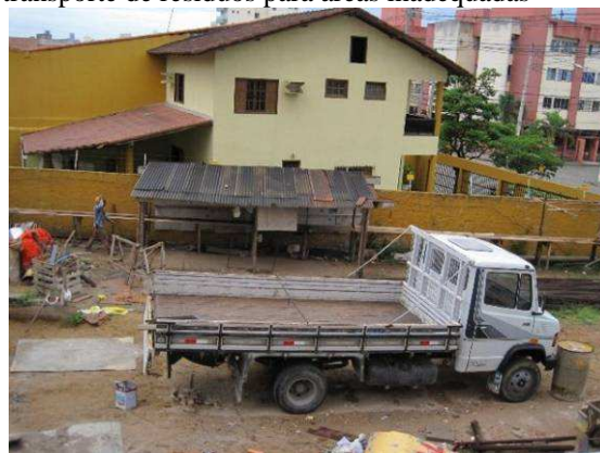
Figura 46 - Veículo da construtora G para transporte de resíduos para áreas inadequadas
