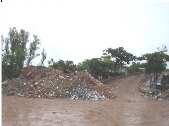
Figura 59 - Pilha de RCC, aguardando triagem no pátio na usina MG 1
