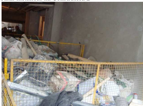
Figura 22 - Separação de resíduos por tipo e em baias metálicas na Construtora B
