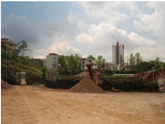
Figura 56 - Vista geral da área de reciclagem da usina MG 3, em Belo Horizonte
