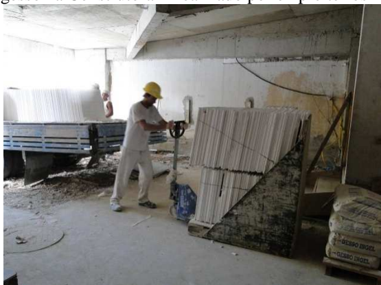
Figura 43 - Sistema para transporte de placas de gesso na Construtora B realizado por empreiteiros
