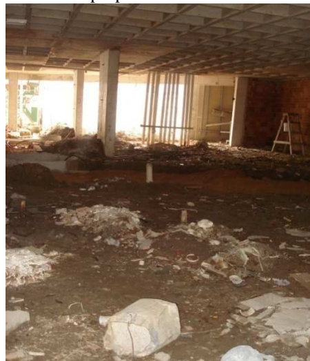
Figura 39 - Aterro do pavimento garagem com resíduos da própria obra na Construtora B
