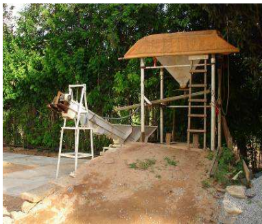
Figura 87 - Piloto do primeiro sistema de lavagem de areia reciclada no Brasil
