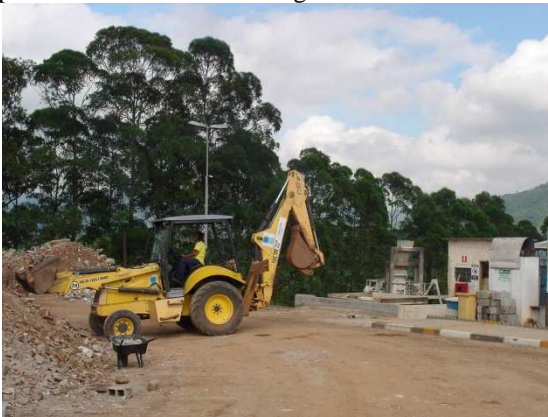
Figura 11 - Transporte de RCC, após a triagem, para o britador na usina Proguaru
