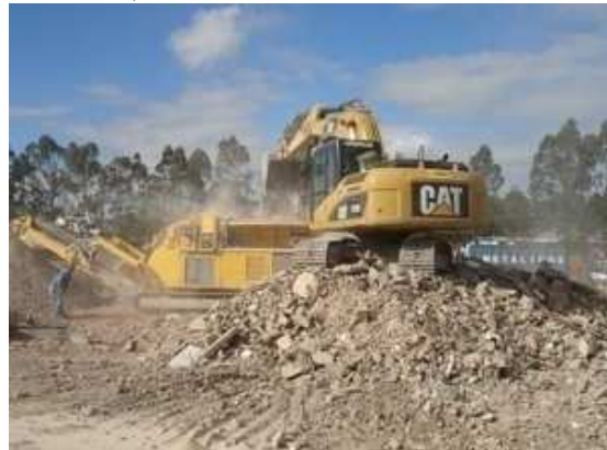
Figura 91 - Reciclagem de concreto pela usina SP 5 em Jundiaí, São Paulo
