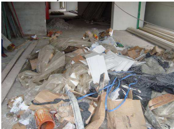
Figura 32 – Mistura de resíduos classes B e D destinados à doação na Construtora A
