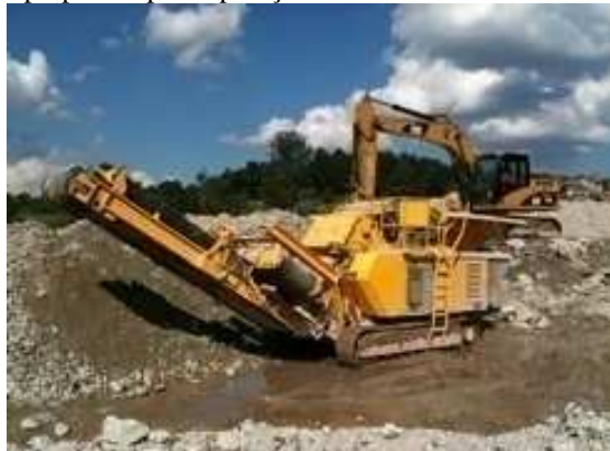
Figura 90 - Vista da usina de reciclagem móvel SP 5 preparada para operação
