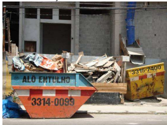
Figura 33 - Baias e caçambas de resíduos destinados à doação na construtora C
