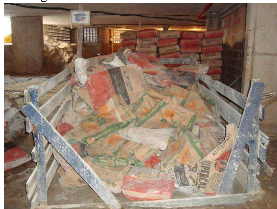
Figura 31 - Baia de madeira para armazenamento embalagens de cimento na Construtora F
