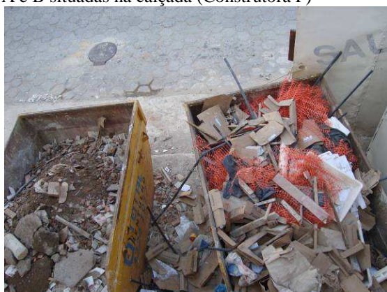
Figura 24 - Caçambas coletoras de resíduos classes A e B situadas na calçada (Construtora F)
