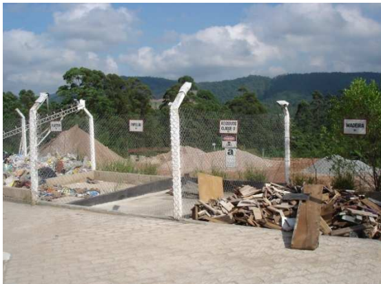
Figura 74 - Baias para armazenamento de contaminantes na usina SP 4
