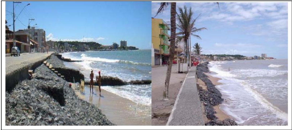
Figura 12: Estruturas construídas para a contenção de erosão na Praia de Marataíes – ES. Fonte: Jacqueline Albino 2004 e 2005, apud Pasolini (2005).
