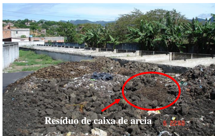
Figura 5.4 – Pátio de estocagem a céu aberto dos resíduos (lodo, resíduo de gradeamento e resíduo de caixa de areia) da ETE Marcílio de Noronha
