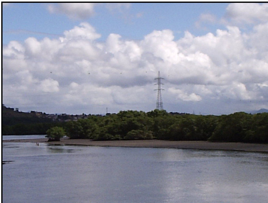
Figura 24. Bairro Goiabeiras - Linha de Energia. (f = 20° 16' 57" S λ = 40° 18' 25" W)
