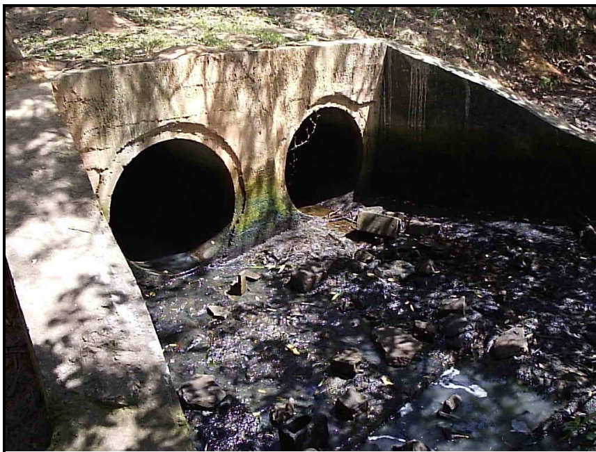
Figura 25. Bairro Joana D'arc – Esgoto . (f = 20° 16' 59" S λ = 40° 18' 45" W)
