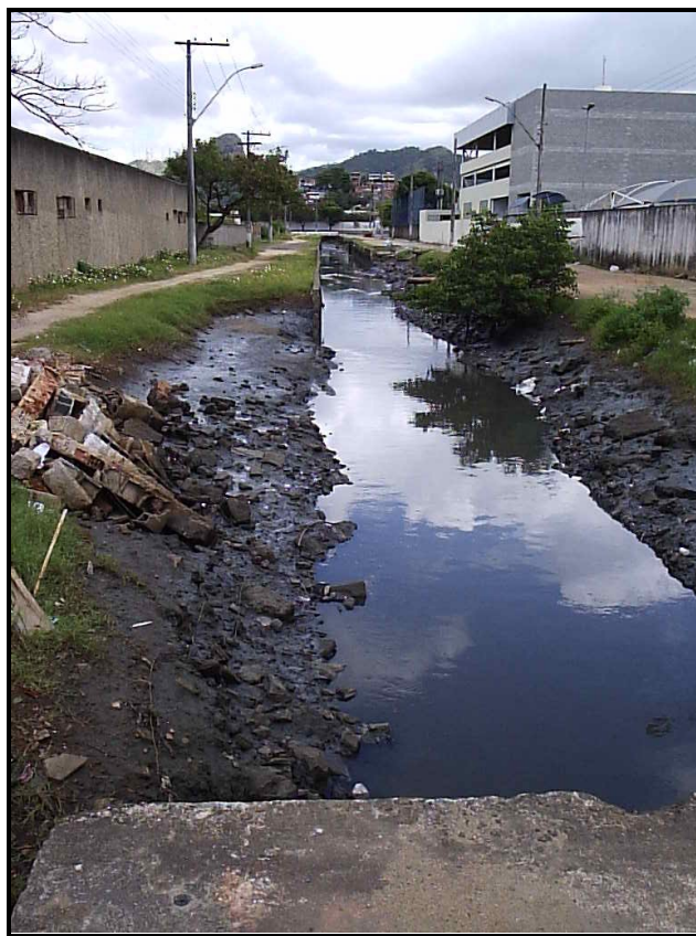
Figura 27. Bairro Santa Luiza – Esgoto (f = 20° 17' 23'' S λ = 40° 18' 03'' W)
