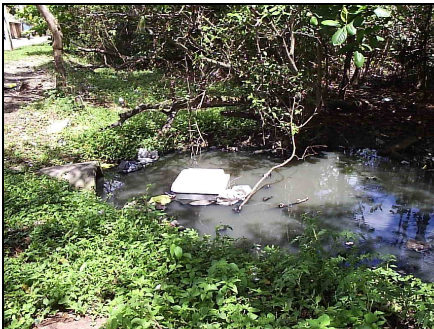
Figura 34. Bairro Nova Palestina – Esgoto (f = 20° 16' 30" S λ = 40° 19' 44" W)
