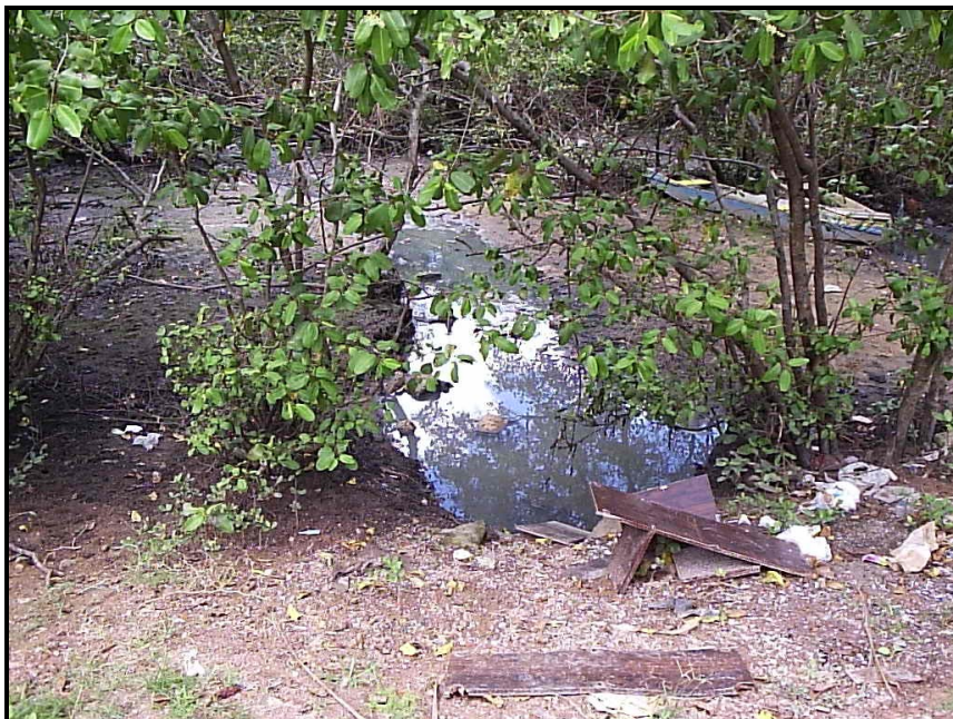
Figura 32. Bairro Resistência – Esgoto (f = 20° 16' 15" S λ = 40° 18' 54" W)
