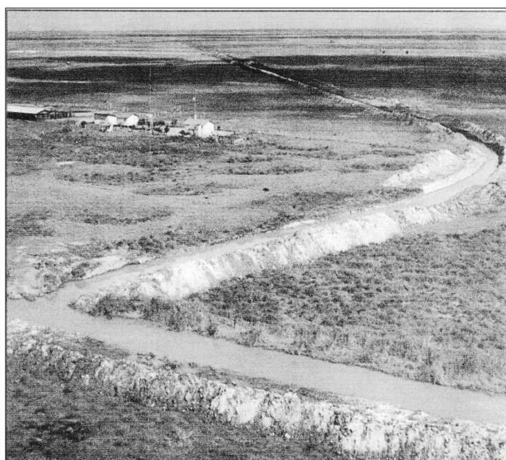
Figura 3 Canal Caboclo Bernardo, visão parcial. Fonte: Aracruz Celulose S.A (2000)
