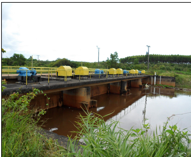
Foto 3: Comporta/barragem móvel no rio Riacho
