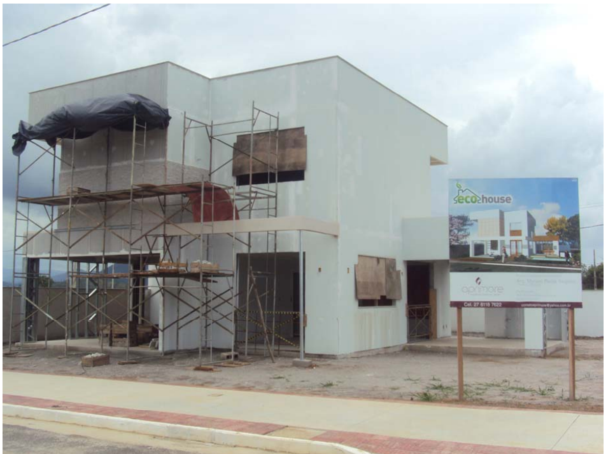
Figura 18: fotografia do local onde está sendo implantado o Vale Verde Residencial
