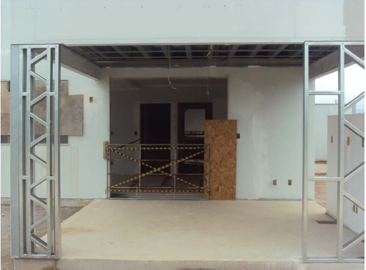
Figura 19: fotografia do local onde está sendo implantado o Vale Verde Residencial
