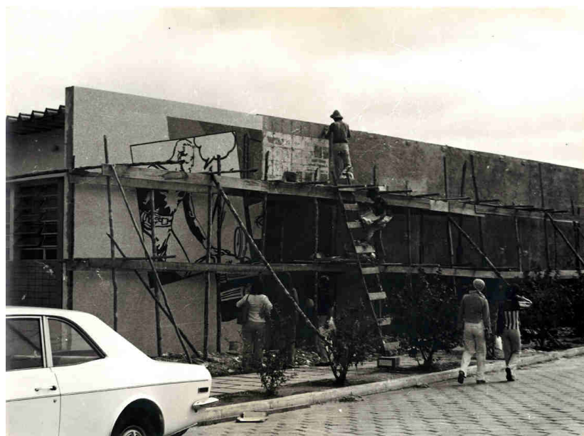
Figura 139: Montagem e fixação do mosaico na parede Fonte: Fotografias de Wallace Neves. Acervo de Raphael Samú
