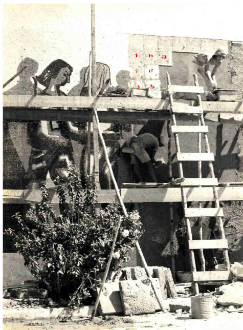
Figura 146: Montagem e fixação do mosaico na parede Fonte: Fotografias de Wallace Neves. Acervo de Raphael Samú
