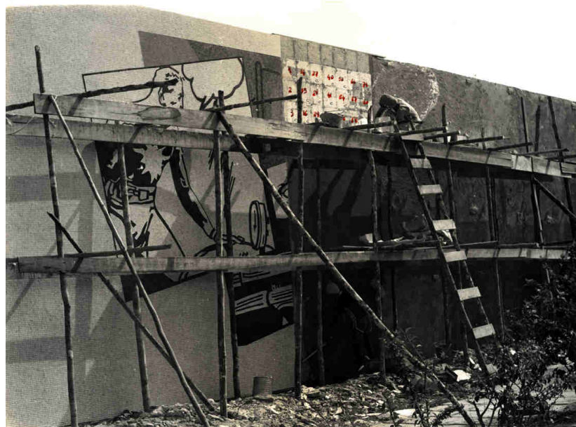
Figura 138: Montagem e fixação do mosaico na parede Fonte: Fotografias de Wallace Neves. Acervo de Raphael Samú
