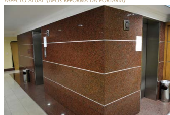
ASPECTO ATUAL (APÓS REFORMA DA PORTARIA)
