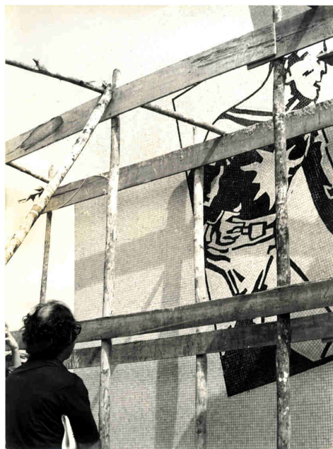
Figura 141: Montagem e fixação do mosaico na parede Fonte: Fotografias de Wallace Neves. Acervo de Raphael Samú
