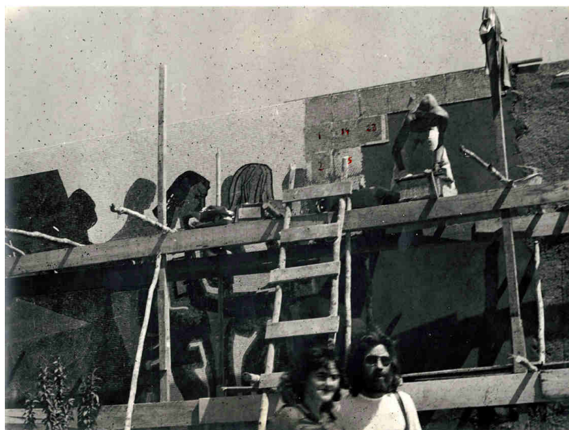
Figura 145: Montagem e fixação do mosaico na parede Fonte: Fotografias de Wallace Neves. Acervo de Raphael Samú
