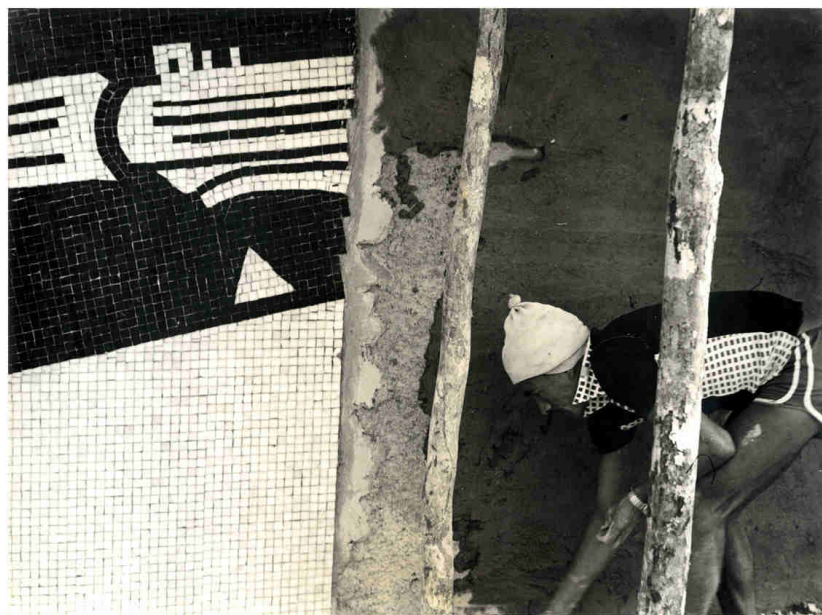
Figura 143: Montagem e fixação do mosaico na parede Fonte: Fotografias de Wallace Neves. Acervo de Raphael Samú
