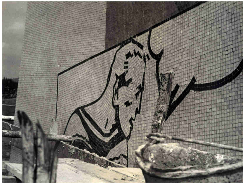
Figura 142: Montagem e fixação do mosaico na parede Fonte: Fotografias de Wallace Neves. Acervo de Raphael Samú
