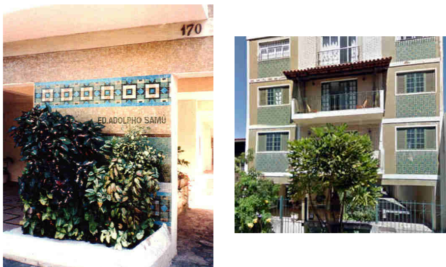
Figuras 93 e 94: Edifício Adolpho Samú, Década de 1980, Vila Velha Fonte: Acervo pessoal do artista Raphael Samú
