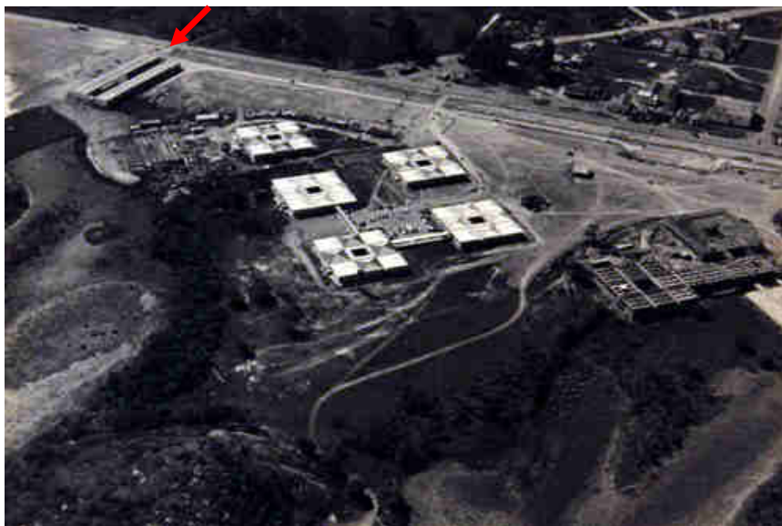
Figura 156: Início das obras do Campus de Goiabeiras da UFES. Pode-se observar, indicado pela seta, o prédio no qual o painel será instalado; ele está na entrada da UFES, de frente a Avenida Fernando Ferrari.
