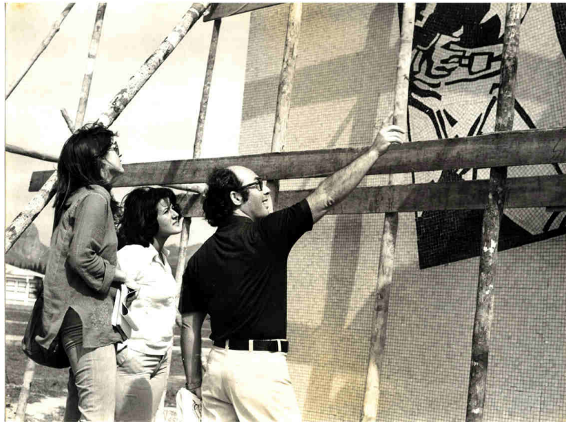
Figura 140: Montagem e fixação do mosaico na parede Fonte: Fotografias de Wallace Neves. Acervo de Raphael Samú
