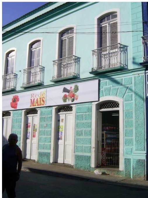
Imagem 25: Placa de publicidade obstruindo parte do imóvel tombado. Fonte: Arquivo da autora/2008.
