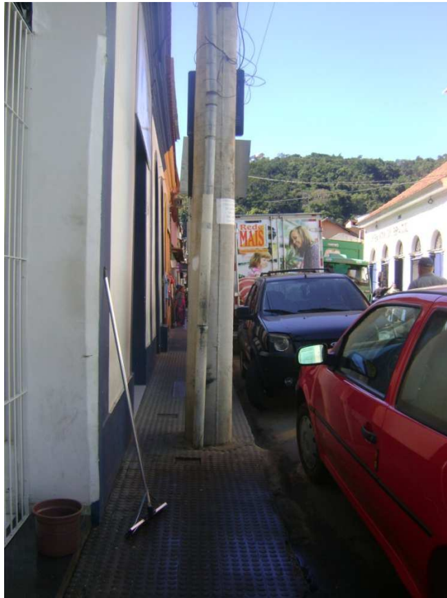
Imagem 39: Na imagem notamos a presença do poste exatamente no meio da calçada, fazendo com que o pedestre utilize a via pública para transitar. Fonte: Arquivo da autora – Julho/2013.
