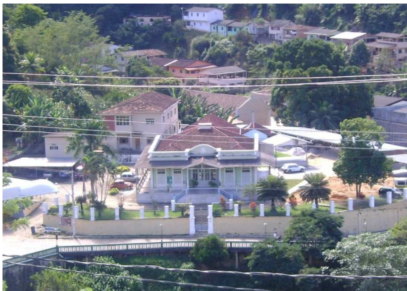
Imagem 12: Imóvel à rua Bernardino Monteiro, localizada no centro do lote. Fonte: Arquivo da autora – Junho/2012.
