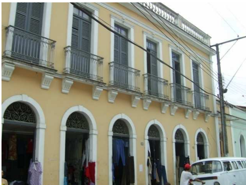
Imagem 37: Fiação elétrica interferindo na imagem de outro imóvel tombado no SHU de Santa Leopoldina. Fonte: Arquivo da autora – Julho/2008
