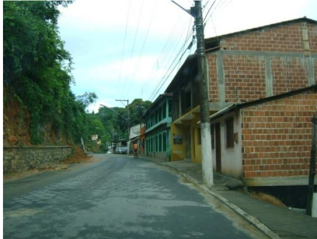
Imagem 16: Entrada leste da sede de Santa Leopoldina. Tipologia construtiva sem apuro formal, uma característica dominante. Fonte: Arquivo da Autora - Novembro/2012.
