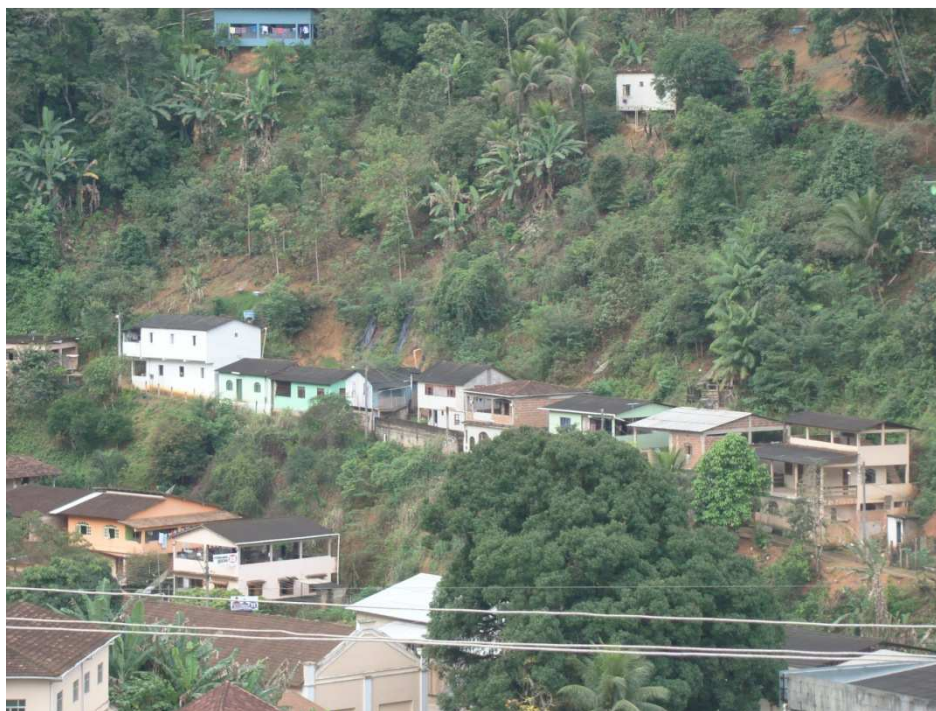
Imagem 42: Ocupação desordenada da encosta. Fonte: Arquivo da Prefeitura – Acesso em Julho/2013.
