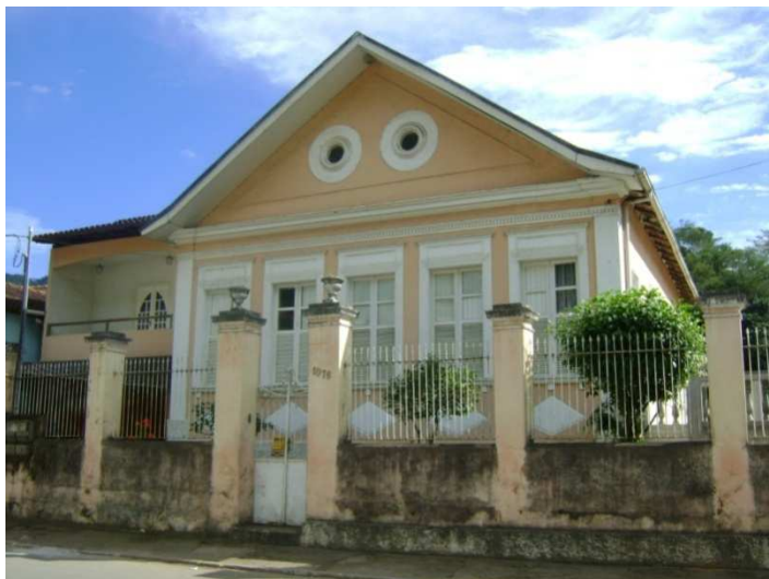
Imagem 13: Imóvel a Rua Jerônimo Monteiro, implantado no centro do lote. Fonte: Arquivo da Autora – Junho/2012.
