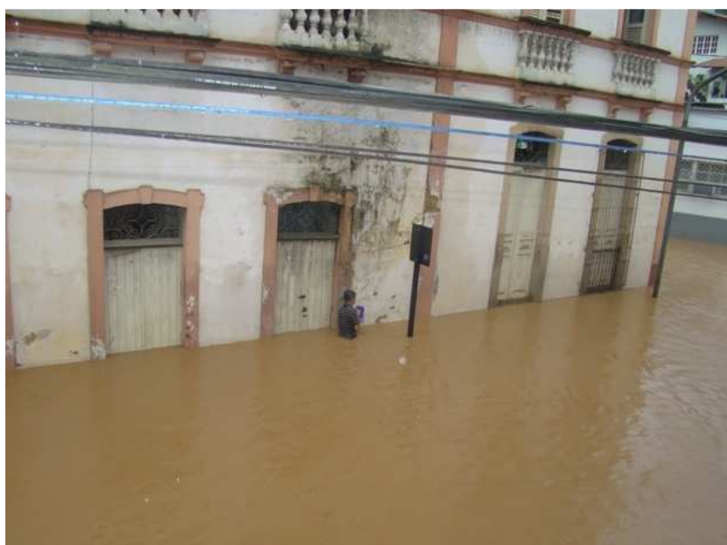
Imagem 41: Registro da enchente de 2012 que inundou vários imóveis tombados da sede.
