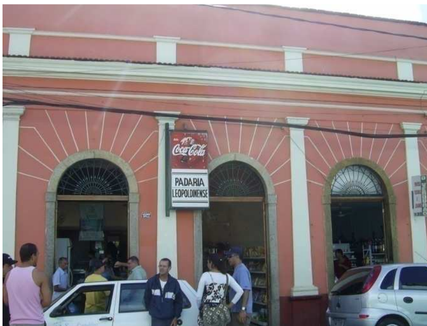
Imagem 36: Fiação elétrica interferindo na imagem do imóvel tombado no SHU de Santa Leopoldina. Fonte: Arquivo da Autora - Julho/2008
