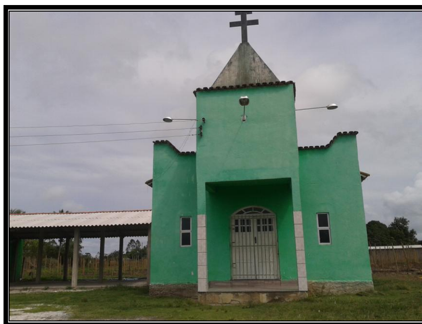
Figura 35: Paisagem da Igreja Católica, localidade de Santa Izabel. Fonte: Júlio de Souza Santos, 2014.
