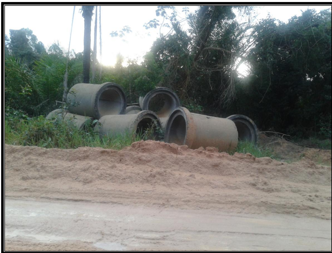
Figura 11: Vista Parcial da Obra de Pavimentação da Rodovia ES-010: Via de Acesso à Itaúnas e ao Assentamento Paulo César Vinha Fonte: Júlio de Souza Santos, 2015.
