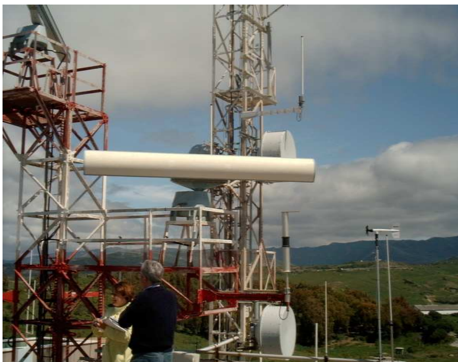
Centro Zonal de Salvamento Marítimo. Tarifa. Antenas de radares Banda X y Banda S.
