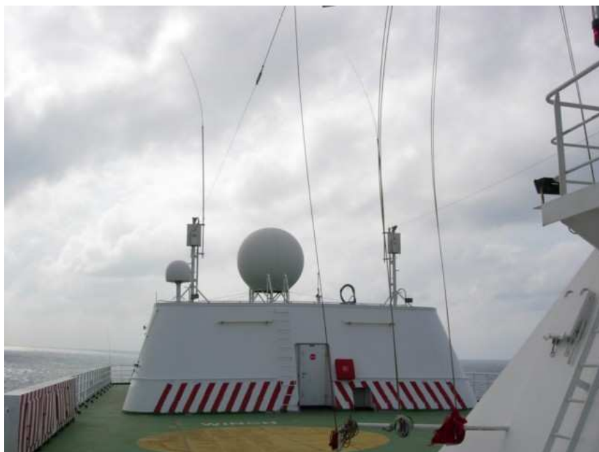
La antena de Onda Corta medida figura a la derecha de la fotografía.
