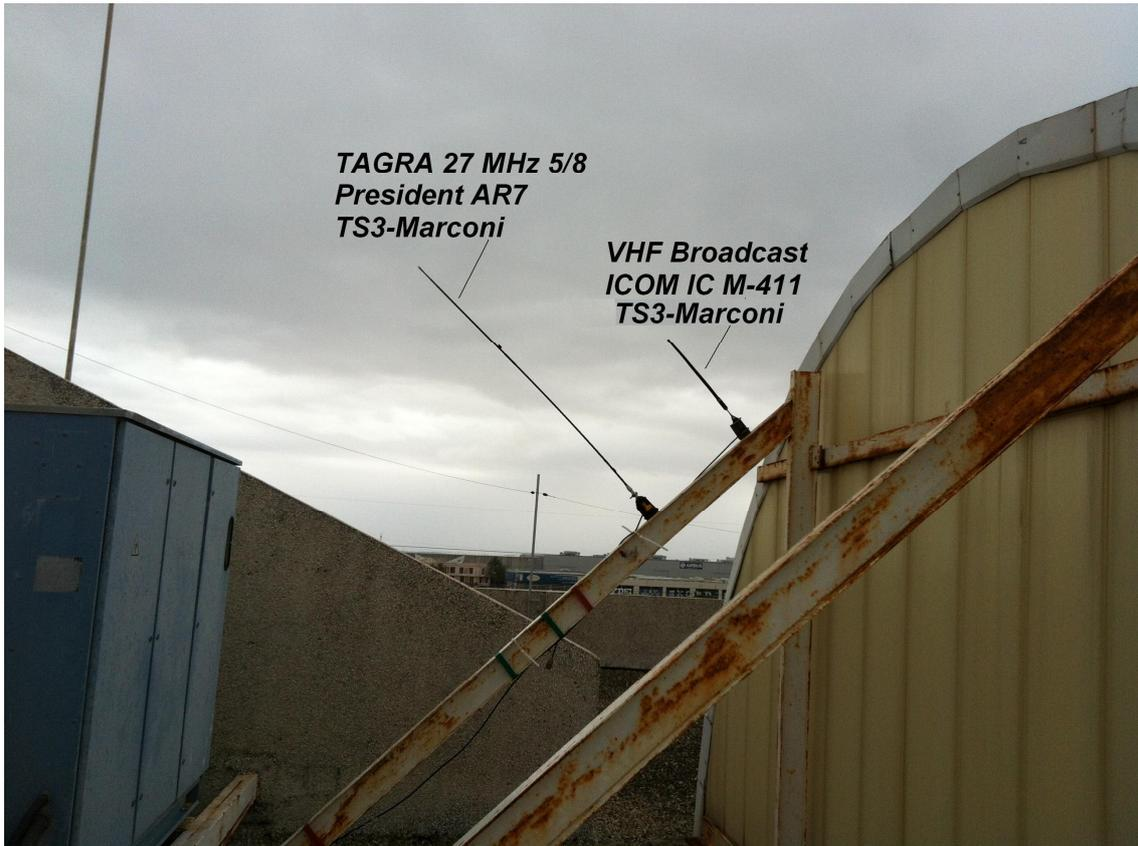
Figura 5.6.27 Detalle de antenas para receptores integrados en Teamspeak.
