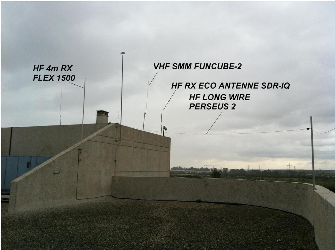
Figura 5.6.25 Detalle de antenas del sistema Marconi para Flex 1500, Funcube, SDR-IQ.
