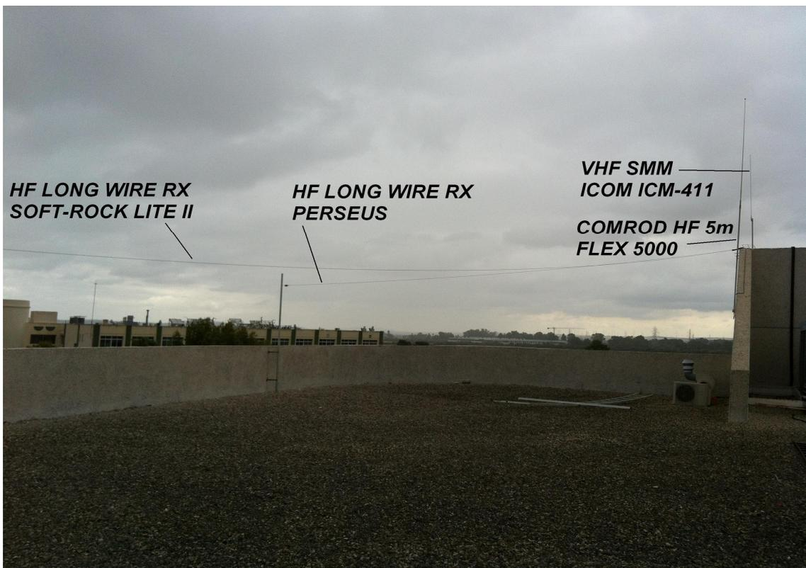
Figura 5.6.26 Detalle de antenas para Softrock, Perseus, Flex 5000 e ICOM ICM-411.
