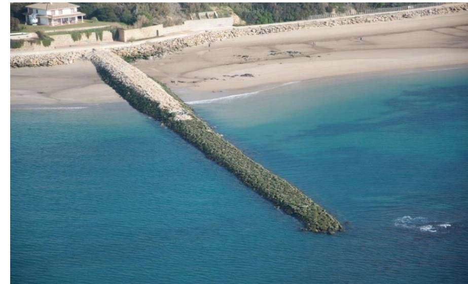
**Figura n°3.** Espigón de nueva construcción en Fuentebravía.
