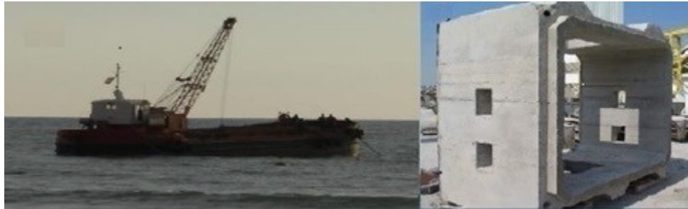
Figura 1. Fotografía del módulo de hormigón prefabricado y del gánguil utilizado para su ubicación
