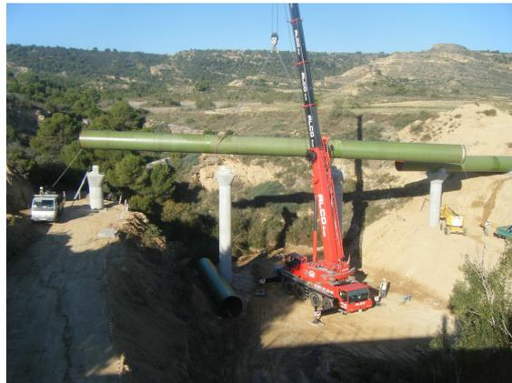
*Figura 3. Montaje de Tubería en Estructura Aérea*
