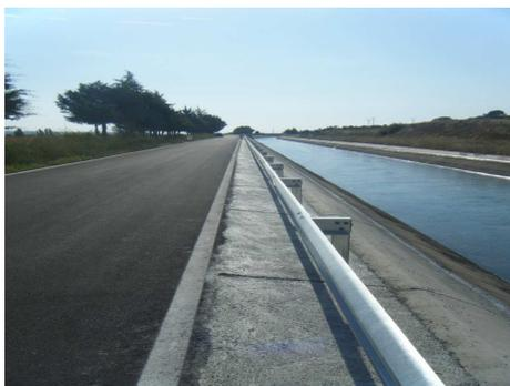
*Figura 2. Detalle de Canal, Camino de Servicio y Banqueta.*
