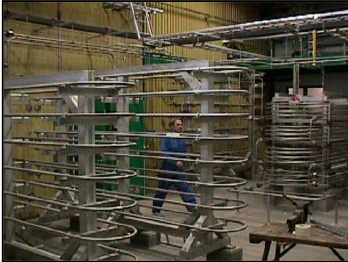
Figura 21. Vista parcial de la planta de Karlskoga.
