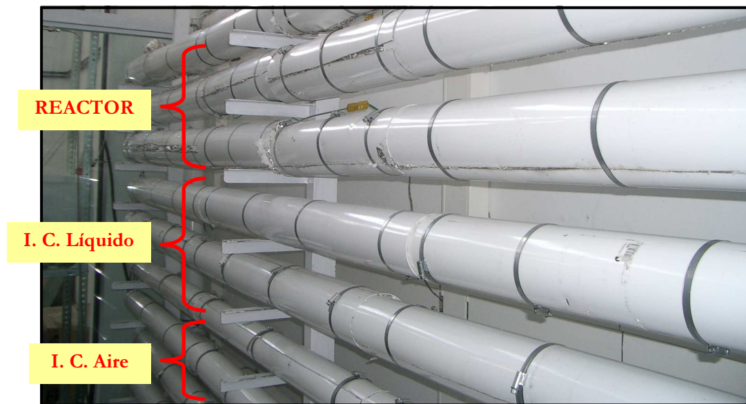
Figura 43. Fotografía de los intercambiadores de calor de tubos concéntricos para el precalentamiento de las corrientes de alimentación líquida y de aire.
