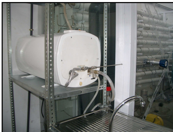
Figura 47. Fotografía del separador gas-líquido.
