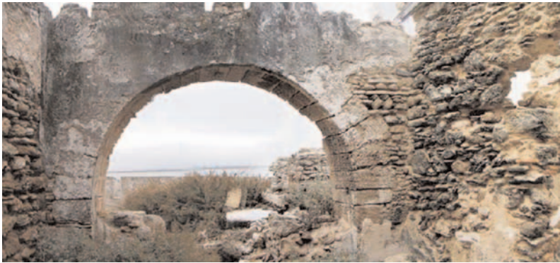
Fig. 6. Vista de un arco de sillería y muros de mampostería previa a la intervención.
