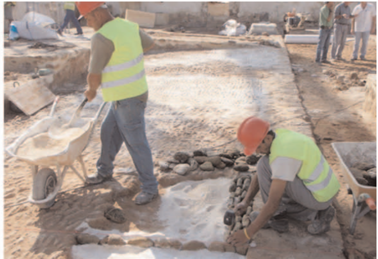
Fig. 10. Limpieza y adecuación del pavimento del pavimento existente y regeneración y reconstrucción de las nuevas zonas.
