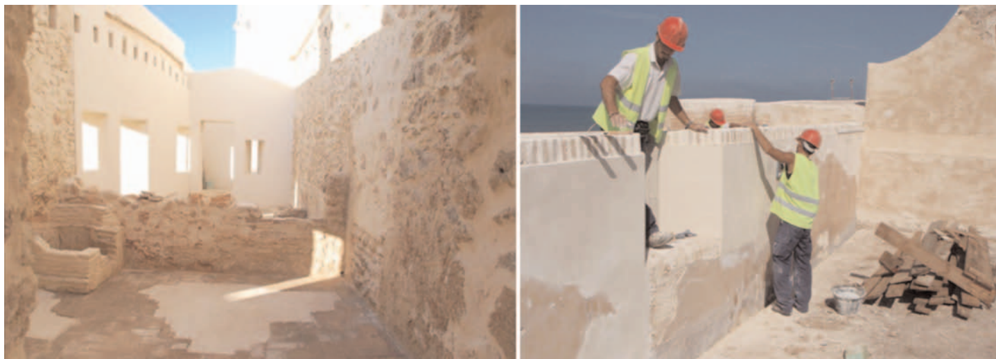
Fig. 8. Diferentes vistas de los acabados dados a las diferentes estancias, piedra vista y enlucido nuevo integrando el existente.
