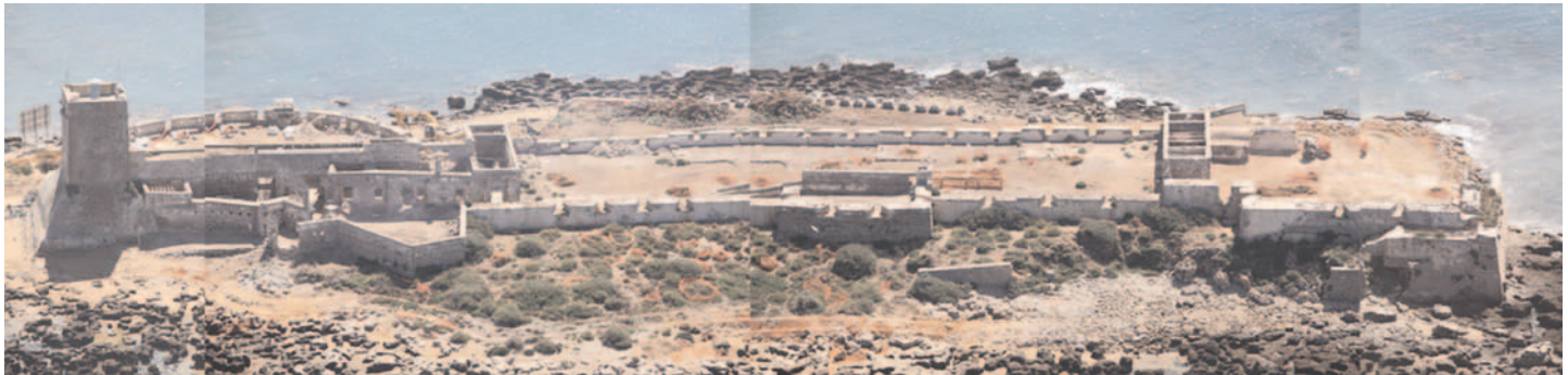
Fig. 2. Vista aérea del castillo una vez finalizadas las tareas de limpieza y desescombro.
