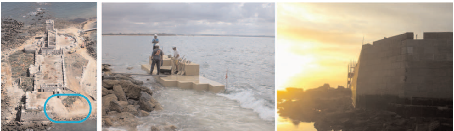
Fig. 7. Diferentes vistas de la reconstrucción del muro de protección marina situado en la zona meridional.
