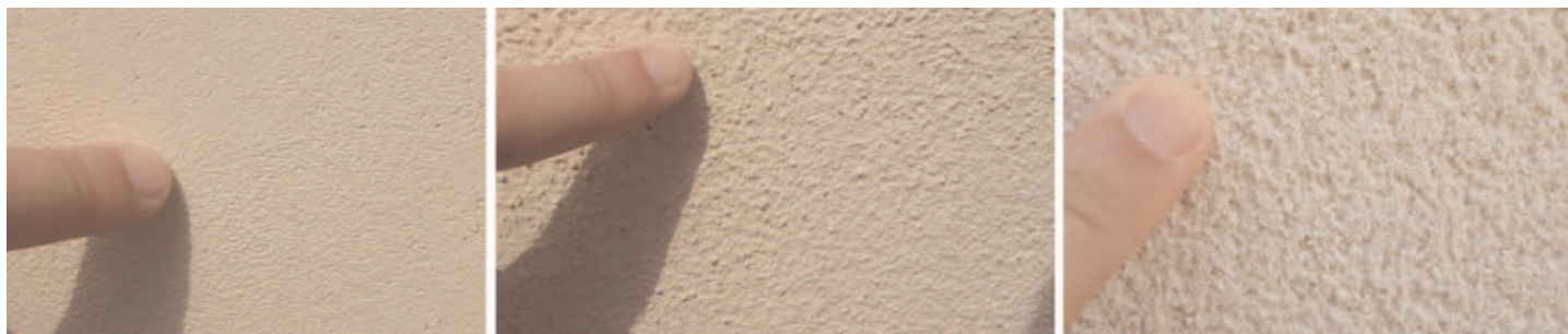
Fig. 15. Vista de distintos acabados de enlucido.
