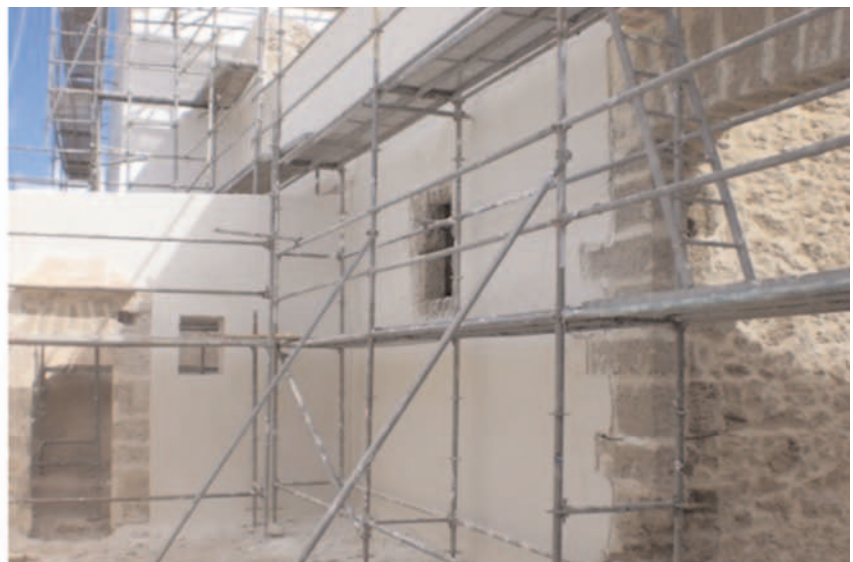
Fig. 11. Vista del acopio de los ladrillos para su posterior reutilización en obra y del acabado dado a los paramentos donde se puede apreciar la sillería vista en marcos y dinteles.
