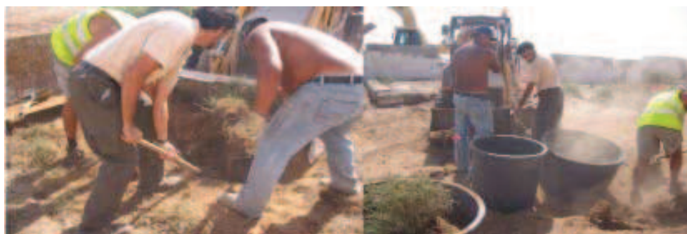
Figuras 8 y 9. Trabajos de extracción
