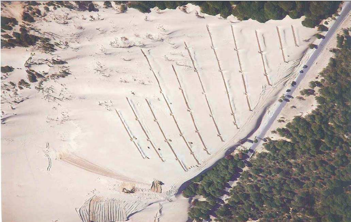
Fig. 5.18. Vista aérea de la situación de la duna en 2006, donde se aprecia que la arena ya traspasó la línea de la carretera. La instalación de tablestacas se realizó entre 2005 y 2006
