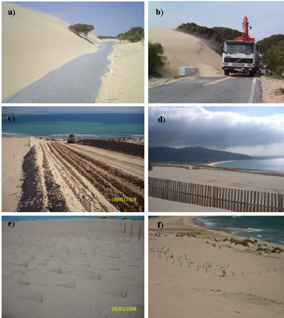
Fig. 3.35. Trabajos de restauración y estabilización realizados en la duna de Valdevaqueros durante los últimos años: a) Estado de la duna antes de las intervenciones; b) Retirada de arenas; c) Remodelación fisiográfica; d) Colocación de tablestacado; e) Plantación de barrón; f) Sistemas de protección y vallado
