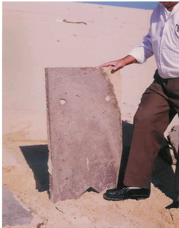
Fig. 3.22. Estructuras de hormigón colocadas a mediados del s. XX (Fuente: Román-Sierra et al., 2004)
