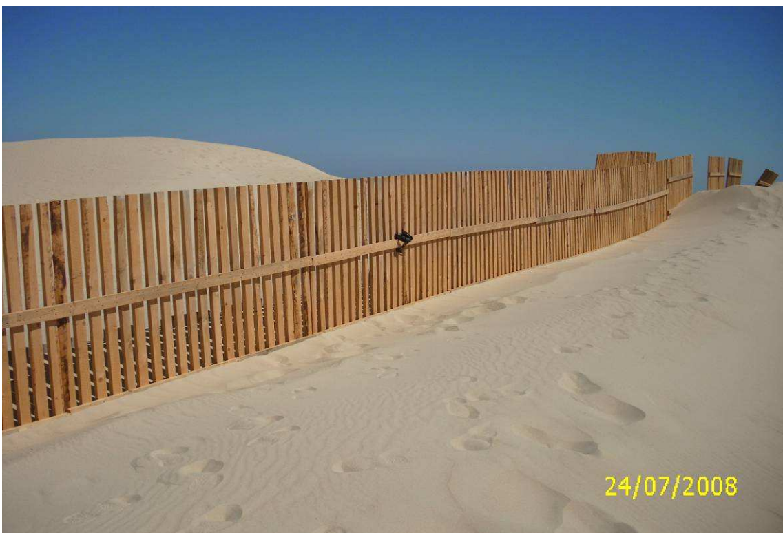
Fig. 3.28. Colocación de tablestacas de madera
