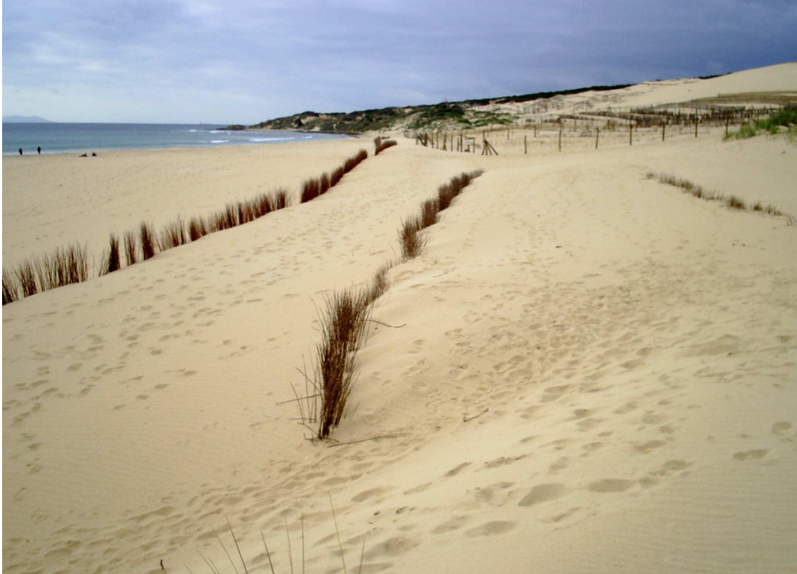
Fig. 3.27. Instalación de captadores de mimbre seco
