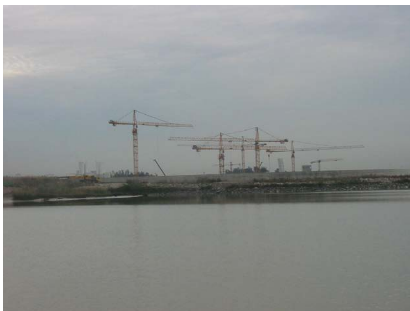
Figura 4-13. Obra de la nueva esclusa de la dársena del Guadalquivir (D).
