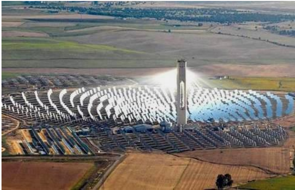
Ilustración 25. Vista de una torre y su campo de helióstatos.
