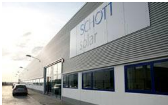
Ilustración 58. Imagen de la planta que tiene la firma Schott en Aznalcóllar (Sevilla) para la fabricación de tubos absorbedores. (Fuente: www.erasolar.es ).
