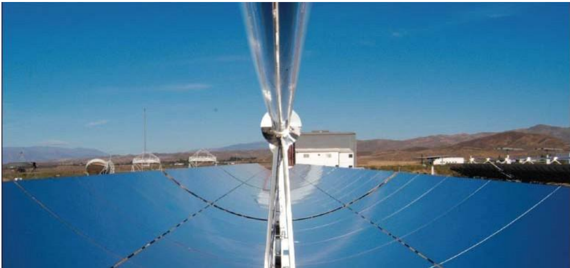
Ilustración 53: Reflector cilíndrico-parabólico (EUROTROUGH. www.nrel.gov )
