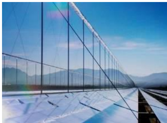
Ilustración 30. Concentrador de Fresnel.
