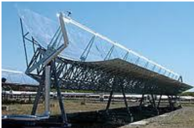
Ilustración 65. Estructura del colector 1. (Fuente: EUROTROUGH www.solarsteamtrain.com ).
