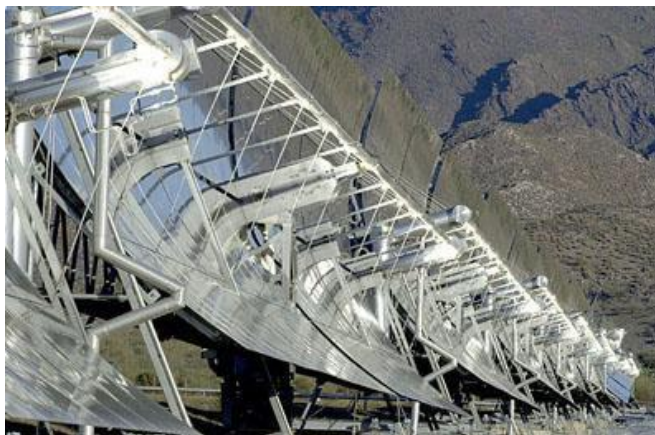
Ilustración 67. Lazo de colectores cilindro parabólico del proyecto DISS en la PSA.
