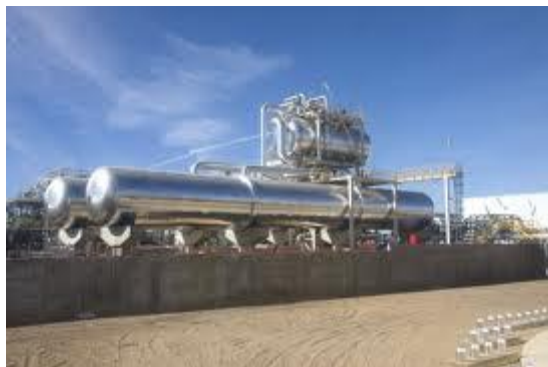
Ilustración 77. Tanques de rebose y de expansión Lebrija I.
