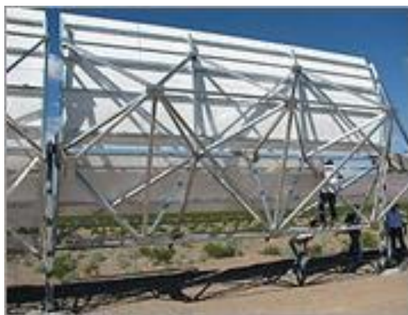
Ilustración 50. Parte de atrás de la estructura de un colector Solargenix. www.nrel.gov
