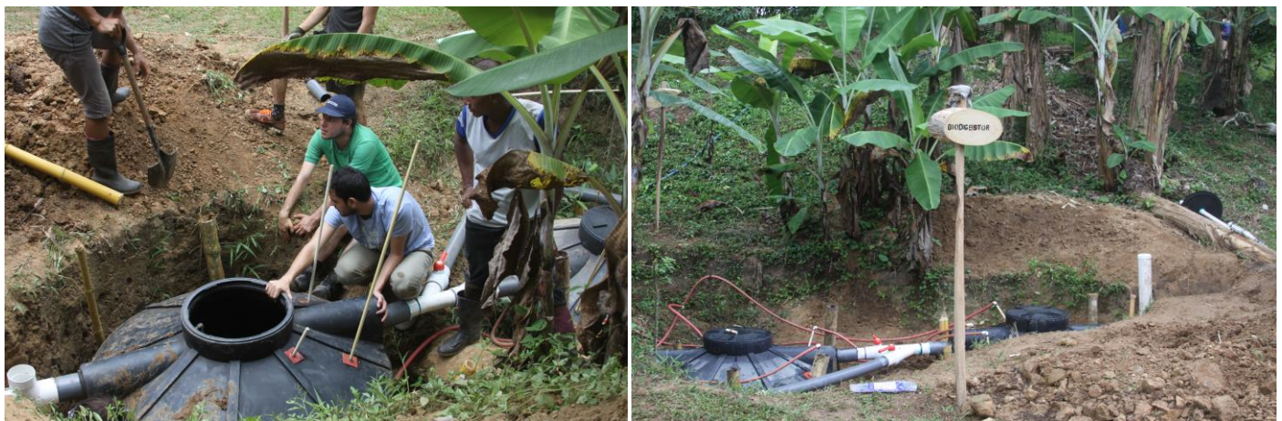
Figura 4. Instalación de biodigestor. A la izquierda sistema de biodigestores instalado.
