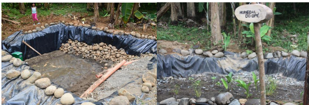
Figura 7. Humedal en construcción y terminado a la derecha.
