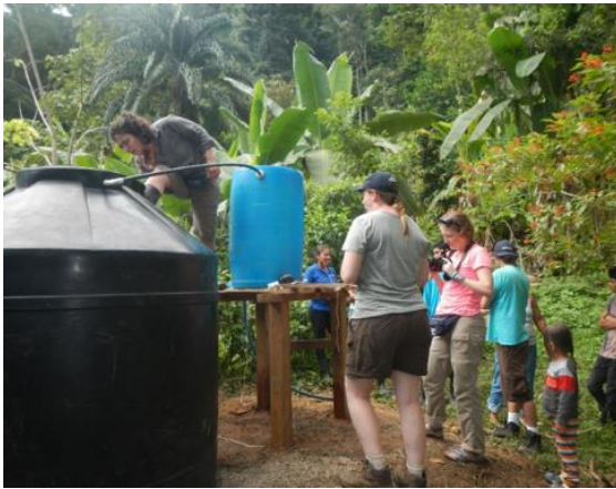
Figura 2. Tanque de almacenamiento y filtro remolino a la derecha.
