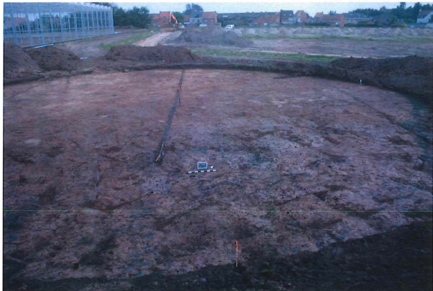
Figuur 5.1. Overzicht van de uitgegraven bouwput voor het waterbassin
