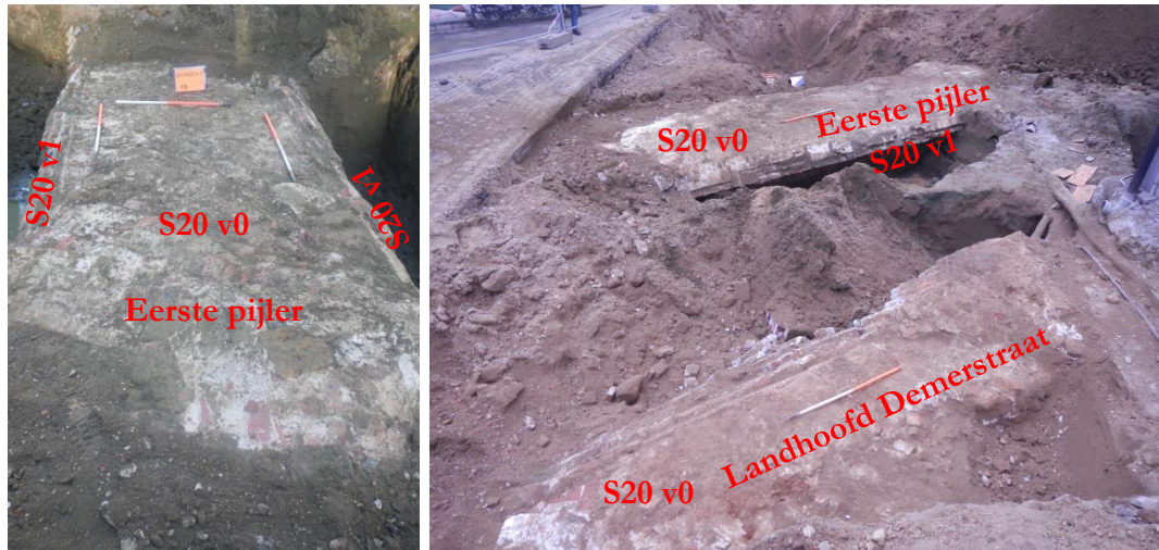
Afbeelding 19: Links de eerste pijler na het landhoofd nabij de Demerstraat (rechts).
