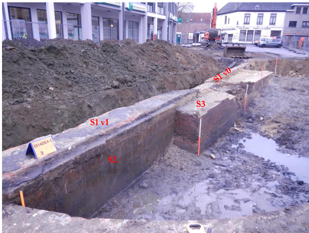
Afbeelding 9: Achterkant van de kaaimuur met aansluiting van de historische paardentrap.
