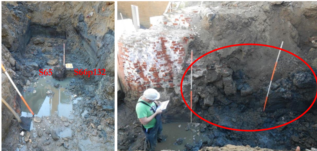
Afbeelding 40: Organische beschoeiing (links) en een ijzerzandstenen vervallen muur (rechts) achter de bakstenen kaaimuur
