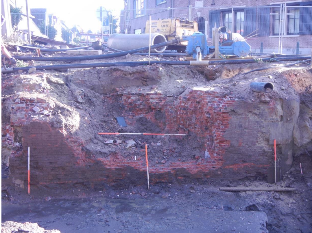
Afbeelding 14: Het landhoofd op de rechteroever (Profiel 7-1).
