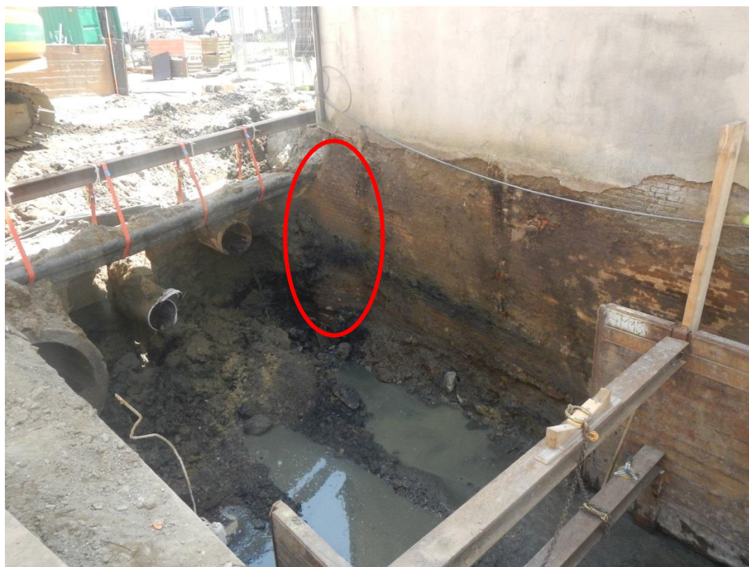
Afbeelding 23: De linkerkaaimuur S18 met een baksteen- en een ijzerzandsteenfase en twee bulten als waterbreker.
