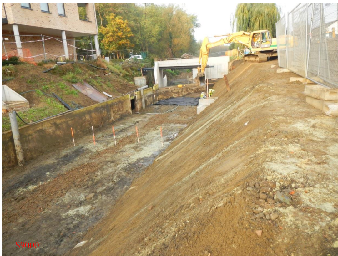
Afbeelding 6: Een boorraai uitgezet door middel van jalons.
