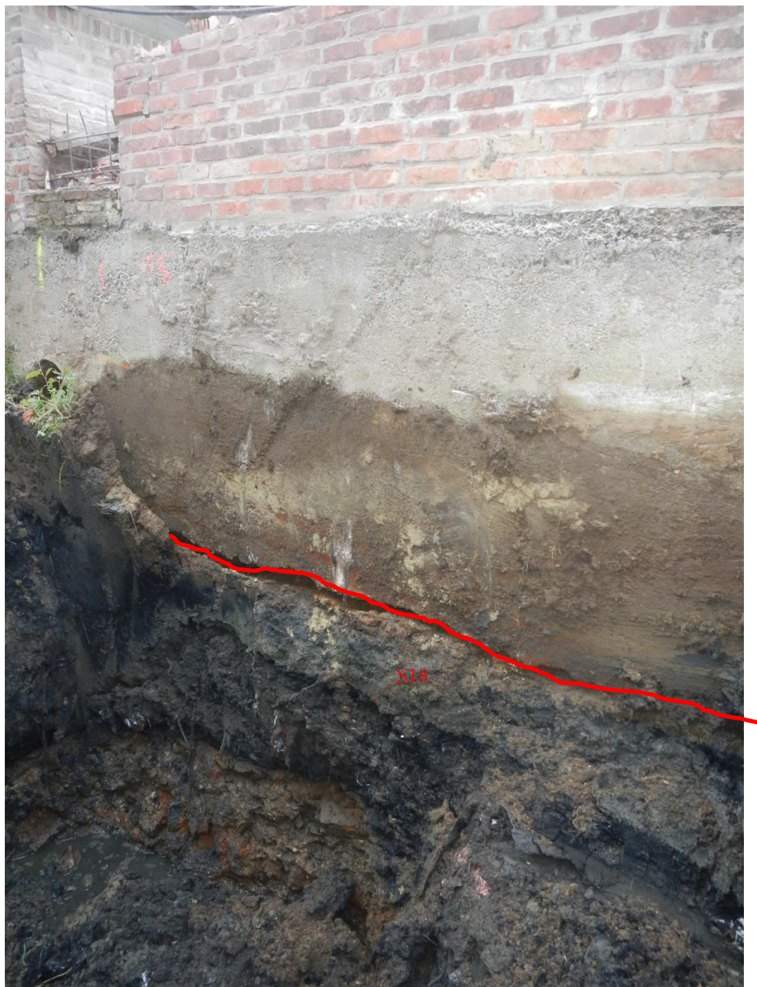
Afbeelding 22: S18, de linkerkaaimuur S18.
