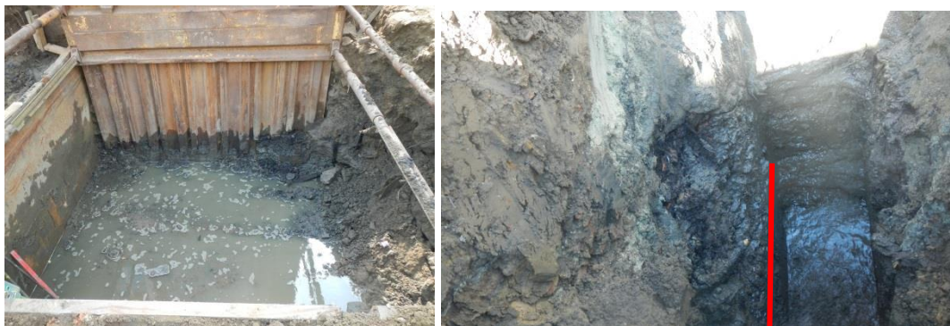
Afbeelding 5: Grondwater dat zich situeerde ter hoogte van de maximale ontgravingsdiepte (links). Het graven van één bak breed nabij een dwarsprofiel met opwellend grondwater. De rode lijn geeft de overgang weer tussen de demp en een natuurlijke onverstoorde kleilaag (rechts).
