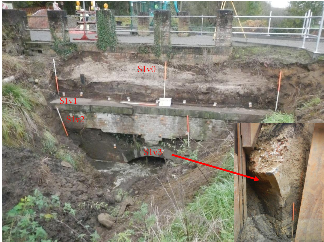
Afbeelding 10: Profiel 2-4 in WP2 met inzet van een detail van de brugboog S1v3 bij de maximale ontgravingsdiepte.
