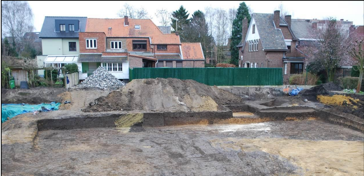
Afb. 13: Zicht op het NO-ZW profiel dat ontstond na de verkleining van de bouwput. In het profiel is de na het vooronderzoek weer opgevulde proefput 2 (PP2) te zien (schuine gele lagen). Rechts hiervan is proefput 4 te zien (PP4) die opnieuw werd leeg gemaakt en opgeschoond. Op de voorgrond zien we de vulling van de grote leemwinningskuil die bijna de volledige werkput in beslag nam. De vulling bestaat uit gemengde donkere, leemkleurige en zandhoudende lagen.
