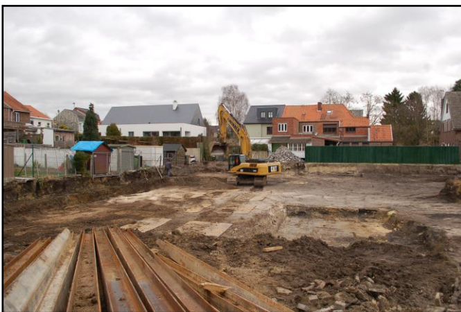
Afb. 9: Begin februari 2014 werd over gegaan tot het plaatsen van een damwand aan de noordwest zijde van de zone met de toekomstige nieuwbouw. (Bron: ARON bvba)
