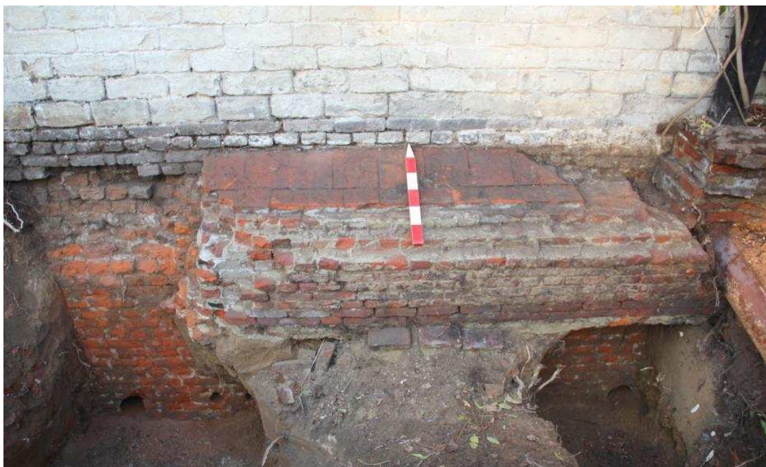
Afb. 8. Zicht vanuit het zuiden op Spoor 1, de structuur in rode baksteen/tegels centraal op de foto. In deze foto zijn verschillende bouwfasen en -stijlen te herkennen. De achtergrond wordt gevormd door de zuidmuur van het hoofdgebouw van het voormalige Kartuizerklooster, waarvan we een deel van het opstaand muurwerk herkennen en van de daaronder liggende kelders (oranje bakstenen, waarvan de bovenste lagen heel sterk verweerd zijn). De gaten in de muren dienen voor de aansluiting van de nutsleidingen.
